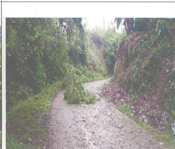
IMAGEN 4: Árboles caídos en carretera vial.
