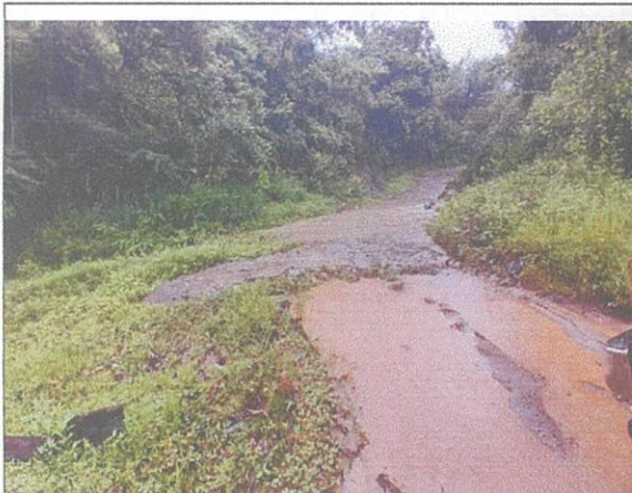
IMAGEN 1: Crecida del rio Pichigua
