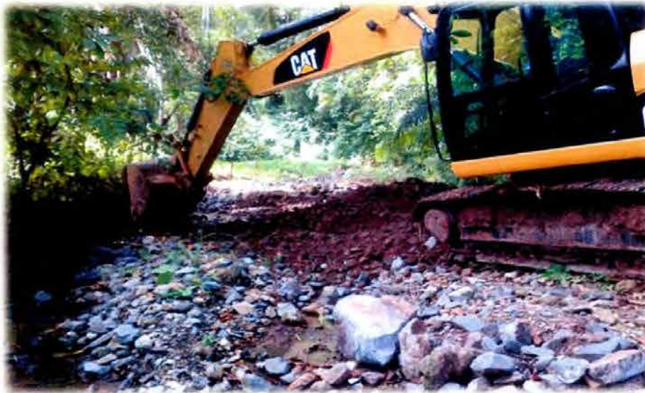
Proyecto de encauzamiento y perfilado de canal de Aguas Lluvias de la Quebrada la Ruidosa en la Aldea la Sarrosa.
