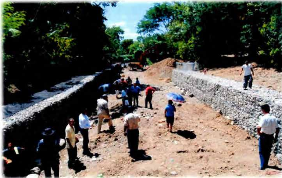
Proyecto de construcción de engavionado en la Represa los Laureles
