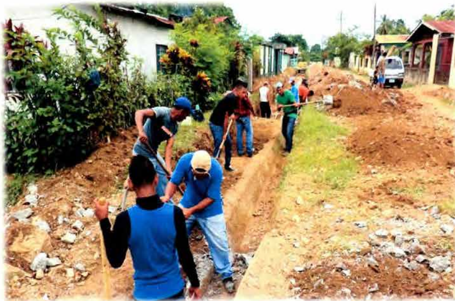
Proyecto de construcción de un canal revestido de concreto (Bloques de concreto).
