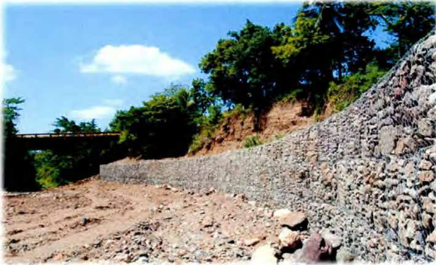
Proyecto de construcción de engavionado en la Represa los Laureles
