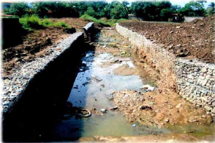
Proyecto de construcción de engavionado del Canal Graham
