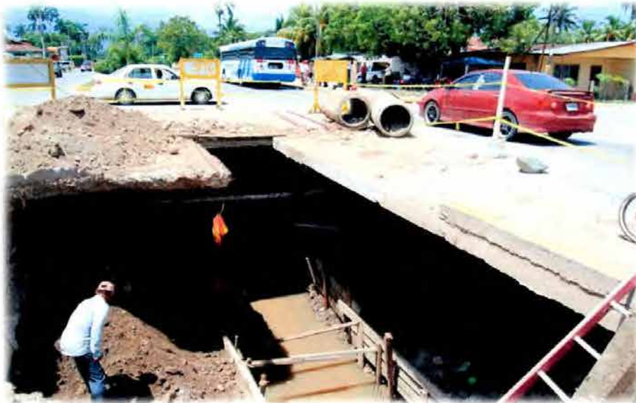
Proyecto reparación de colector Sanitario del Proyecto de Construcción de las Lagunas de Oxidación.
