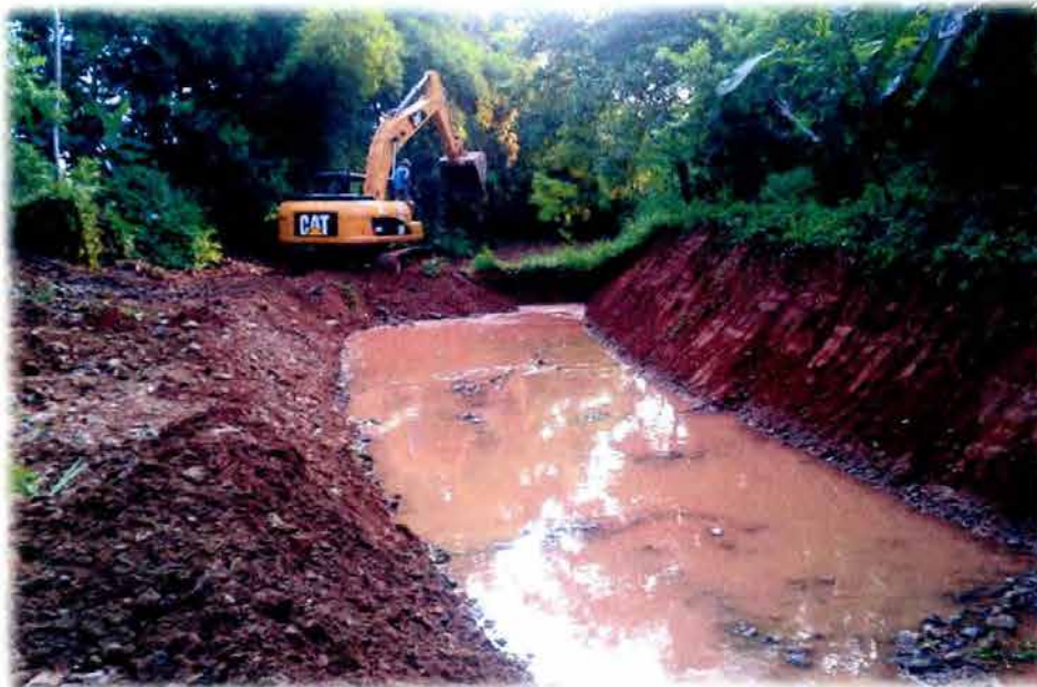
Proyecto de encauzamiento y perfilado de canal de Aguas Lluvias de la Quebrada la Ruidosa en la Aldea la Sarrosa.
