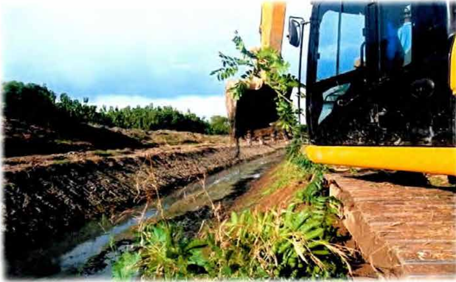
Proyecto de encauzamiento y perfilado de canal de Aguas Lluvias de la Colonia Fatima, San Martin, Centroamericana.
