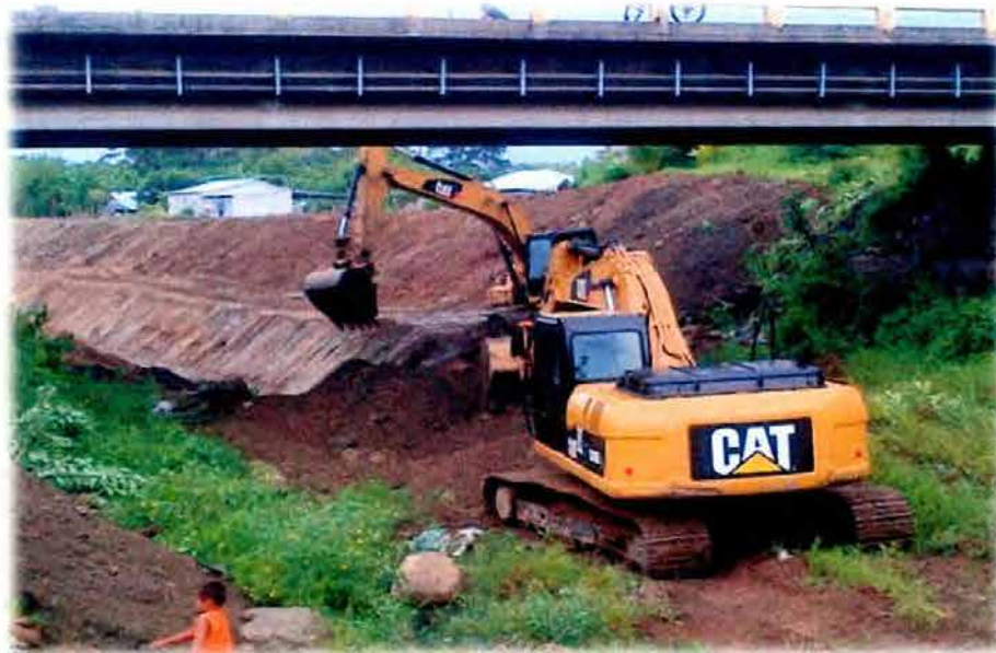
Proyecto de encauzamiento y perfilado de canal de Aguas Lluvias del Barrio Quebrada Seca y el Sector Sur – Este.
