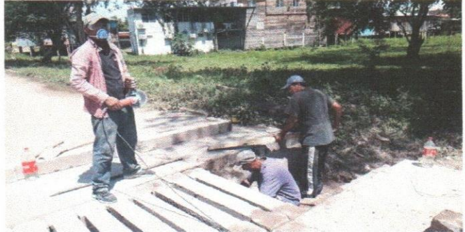
Vigas I Palmira
