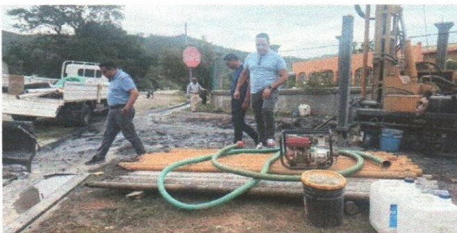
Agua Potable La Balsa
