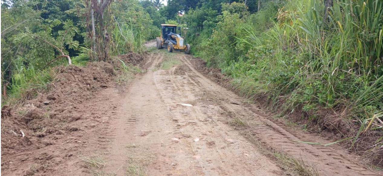
Trabajo de escarificado, conformación, cuneteo y vibrado de calles del barrio El Cielito.
