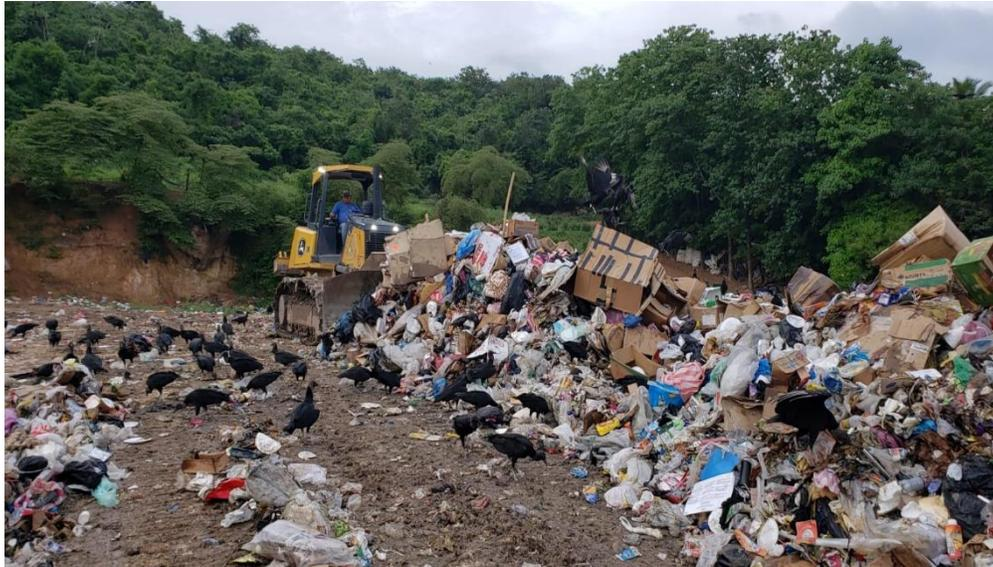
Se aprecia la máquina Bulldozer municipal en trabajos de empuje y soterramiento de basura en el relleno sanitario.
