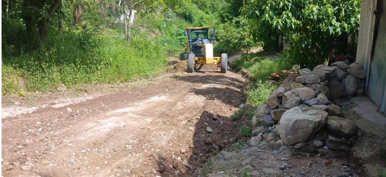
Trabajo de escarificado, conformación, cuneteo y vibrado de calles del barrio Suyapa.
