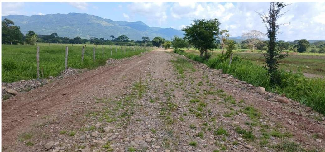
Trabajo de escarificado, conformación y cuneteo de calle en la colonia Miravalle.
