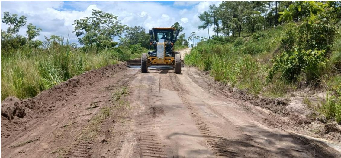
Trabajo de limpieza, ampliación y vibrado de calles de Agua Blanca.
