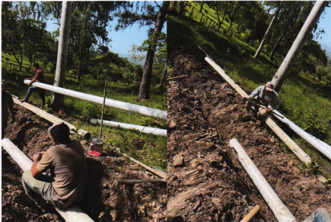
*Reparaciones de tramos de tubería en Línea de Conducción de Río Hondo.*
