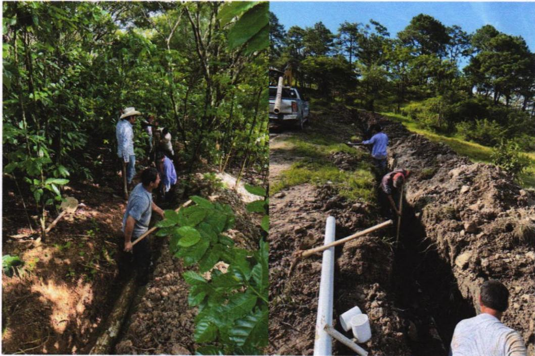
*Reparaciones de tramos de tubería en Línea de Conducción de Rio Hondo.*
