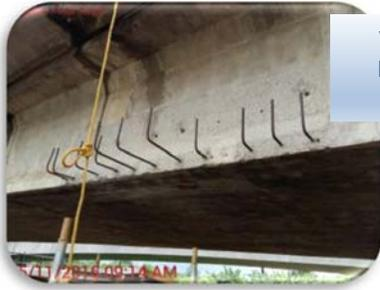
Vista de armado en proceso para bloques de anclaje para cierre de dovelas, Puente La Democracia.
