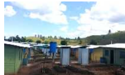
Ilustración: Letrinas instaladas, Departamento de Olancho, 2015.
