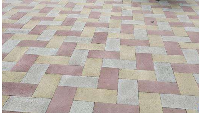
Fig. 3.19 – Instalación tipo Atlanta
