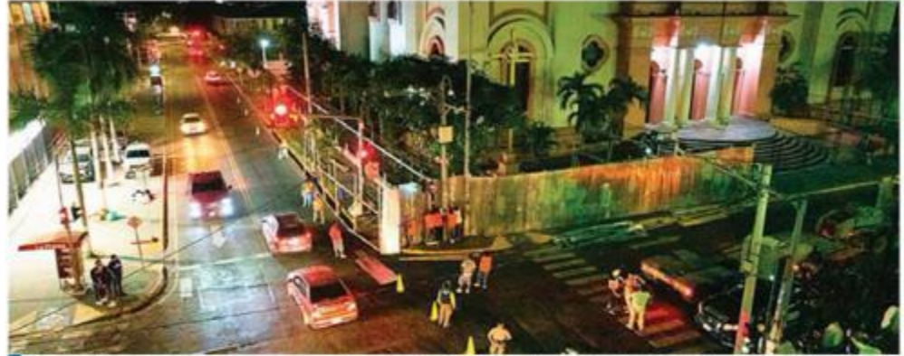
Las láminas se colocaron para prevenir cualquier incidente durante los trabajos de restauración de la Catedral.
