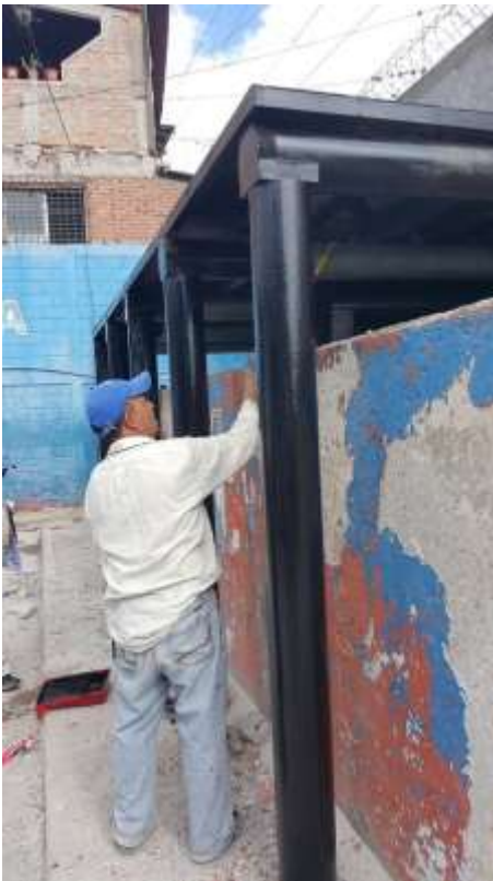
AVANCES DE PROYECTOS VARIOS EN EL MERCADO SAN PABLO BASES PARA SOPORTE DE NUEVO SISTEMA DE ALMACENAMIENTO DE AGUA
