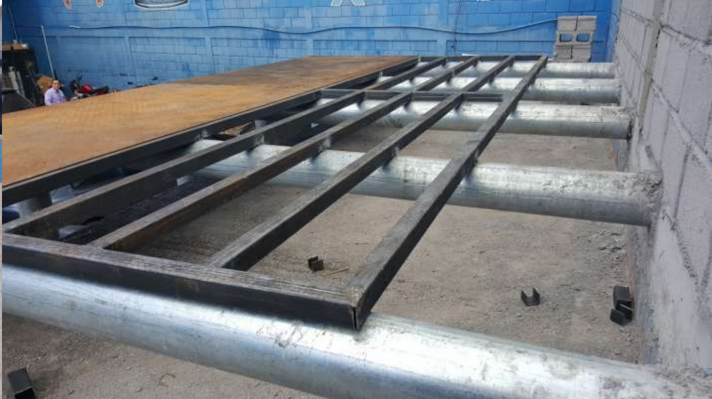
AVANCES DE PROYECTOS VARIOS EN EL MERCADO SAN PABLO BASES PARA SOPORTE DE NUEVO SISTEMA DE ALMACENAMIENTO DE AGUA
