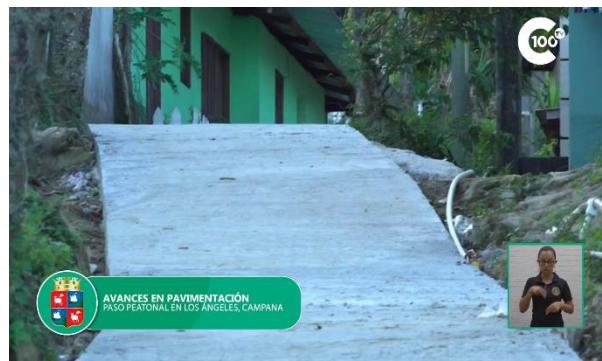
Pavimentación col, los ángeles
