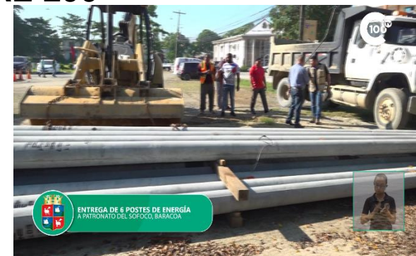
Instalación de postes
