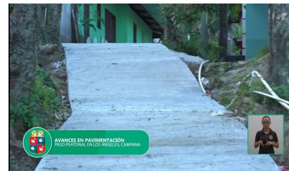
Pavimentación col, los ángeles
