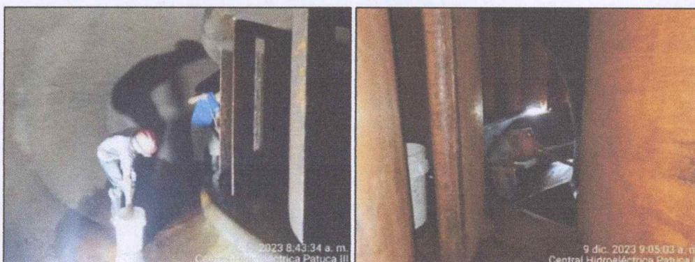
**Instalación de iluminación y trabajos de limpieza de los Álabes fijos y móviles de la Unidad No. 2**
