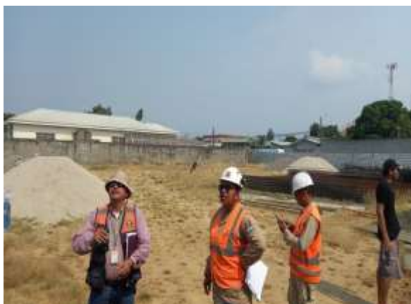
Inspección Construcción y operación de una plaza comercial denominada PLAZA MAR.
