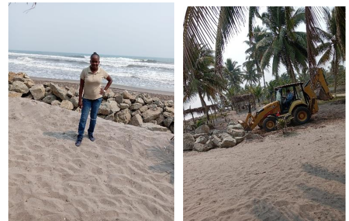
Seguimiento construcción Rompe Olas sector Garífuna, travesía, 14 mayo 2024, 9.00 a.m. Asistente Wendy Arauz
