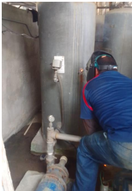
Suministro e Instalación de Tanque de Fibra para agua potable que abastece instalaciones de Estadio Excelsior.
