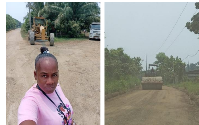
Mantenimiento de calle sector Garífuna Lugar Las brisas, 9.00 a.m. 27 mayo 2024, asistente Wendy Arauz
