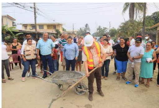
Entrega Orden de inicio pavimentación 12 y 13 calle, 9 a 13 avenida y 9 a 10 avenida, Barrio San Martín. 27 mayo 2024, 5.00 p.m. Nora Velásquez
