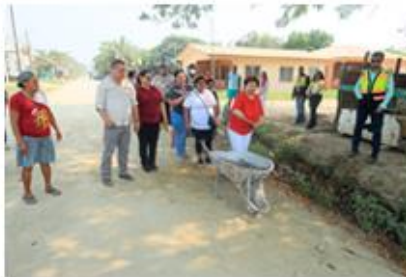
ORDEN DE INICIO CANALES PLUVIALES BO. BUENOS AIRES
