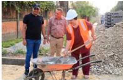
ORDEN DE INICIO CANALES PLUVIALES BO SUYAPA
