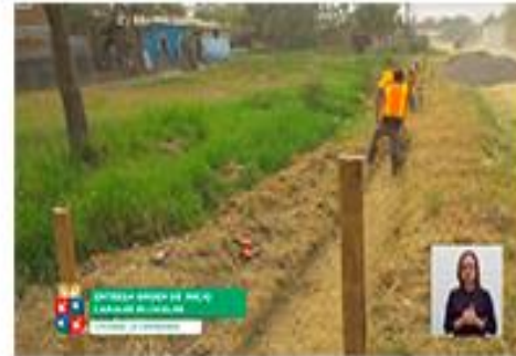
ENTREGA ORDEN DE INICIO CANALES PLUVIALES COOL, LA ESPERANZA ESCUELAS
