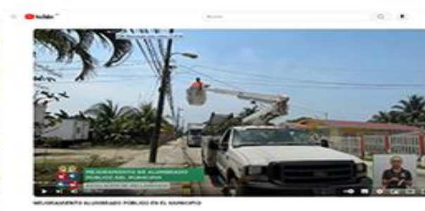
MEJORAMIENTO DE ALUMBRADO ELECTRICO
