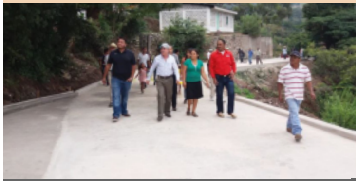
Para 2017 se prevé que finalicen los trabajos de pavimentación en La Flor, Comayagua.
