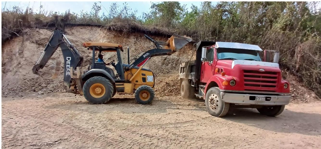
Se aprecia la maquinaria municipal realizando trabajo de corte y carga de material selecto para balastado de calles de aldea El Zanjón.
