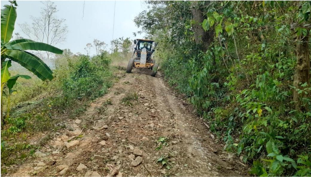
Se observa la máquina realizando trabajo de escarificado, conformación, cuneteo y vibrado en calles de caserío Las Niguas.
