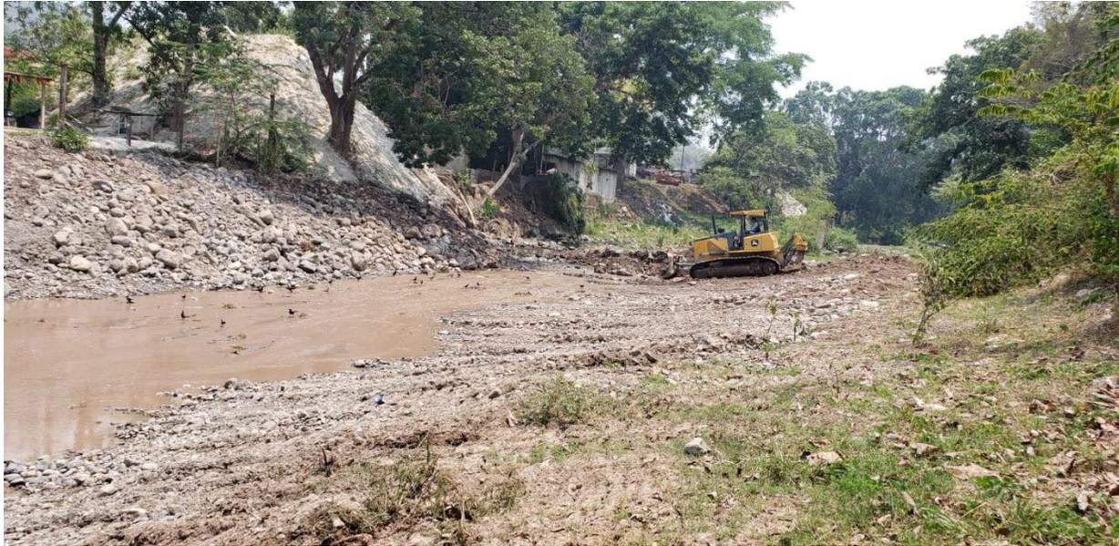
Se observa la máquina municipal realizando trabajo de dragado del río Tepemechín, a la altura del barrio Buenos Aires.
