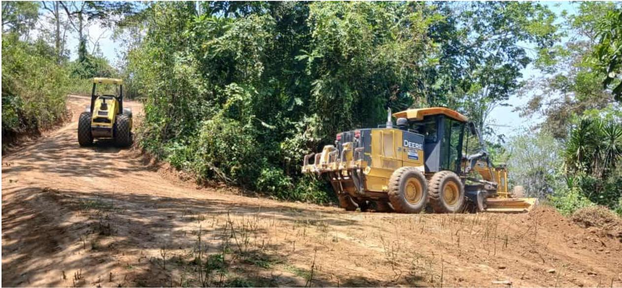
Se aprecia la maquinaria municipal en trabajo de escarificado, conformación, cuneteo y vibrado en calle que conduce de aldea El Cedral hacia aldea Chalmecha.
