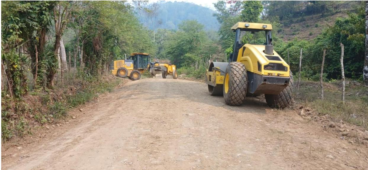
Se aprecia la maquinaria municipal en trabajo de escarificado, conformación, cuneteo y vibrado en calle que conduce de aldea El Zanjón hacia aldea Chalmeca.
