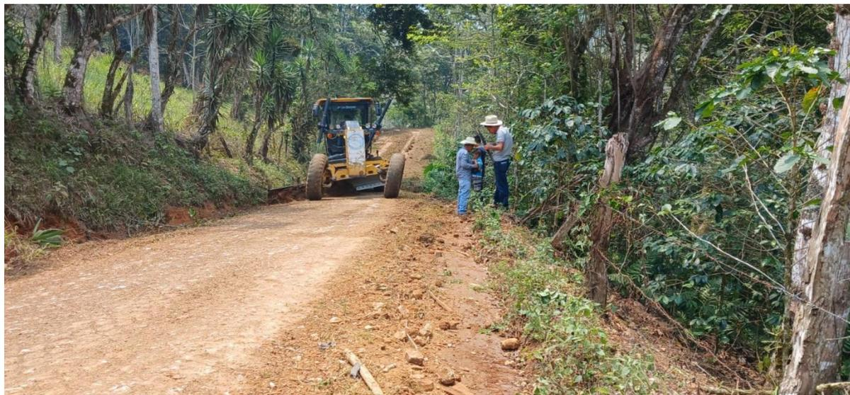
Se aprecia la maquinaria municipal en trabajo de escarificado, conformación, cuneteo y vibrado en calle que conduce de aldea Las Conchas hacia aldea Chalmeca.
