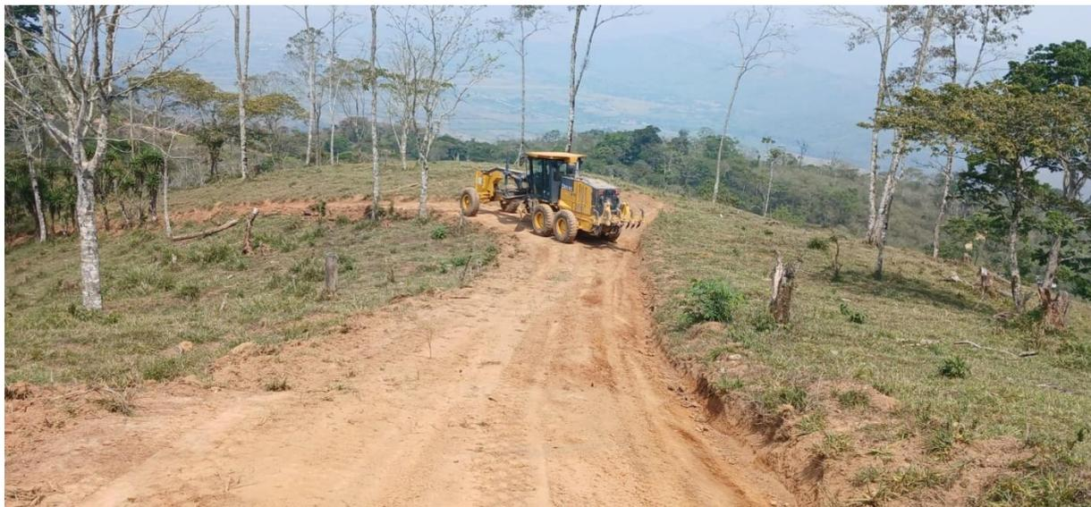
Se observa la máquina realizando trabajo de escarificado, conformación, cuneteo y vibrado en calles de aldea Las Conchas.
