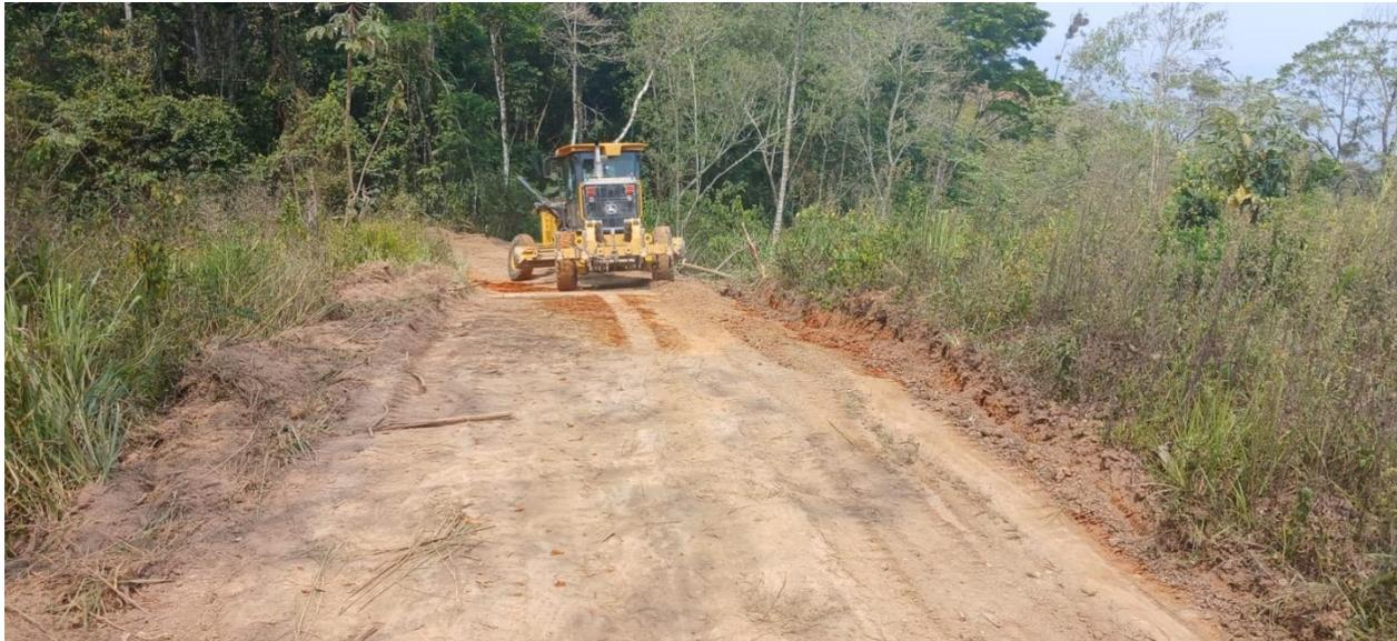
Se observa la máquina realizando trabajo de escarificado, conformación, cuneteo y vibrado en calles de aldea El Cedral.
