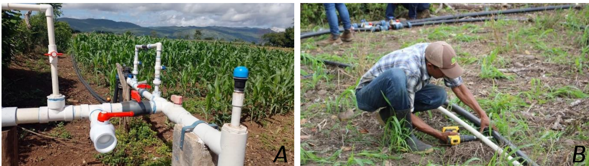
Foto 9. Establecimiento de estructuras para sistemas de riego, A. Gravedad, B. Goteo
