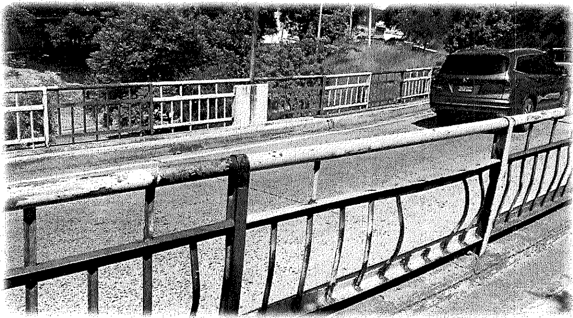
En la imagen se muestra la necesidad de reparaciones puntuales y pintura en barandales metálicos
