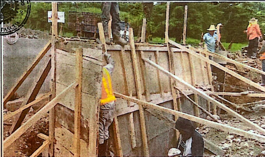
CONSTRUCCIÓN DE CAJA PUENTE EN CRUCE DE QUEBRADA ENTRE LAS COMUNIDADES DE EL TESORO Y LAS FLORES, EN EL MUNICIPIO DE EL PARAISO COPAN
