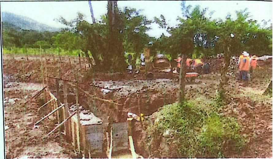
CONSTRUCCIÓN DE CAJA PUENTE EN CRUCE DE QUEBRADA ENTRE LAS COMUNIDADE EL TESORO Y LAS FLORES, EN EL MUNICIPIO DE EL PARAISO COPAN
