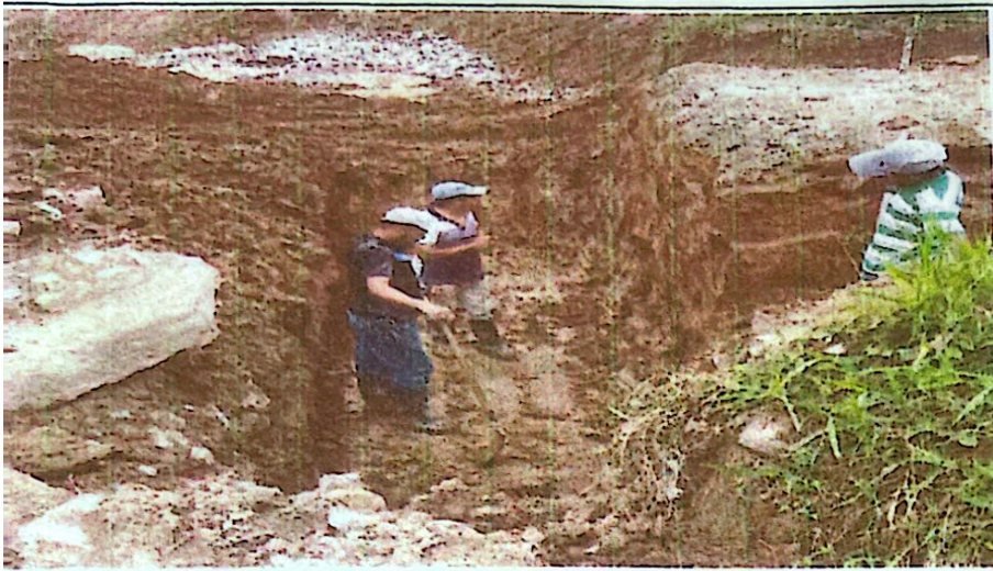
CONSTRUCCIÓN DE CAJA PUENTE EN CRUCE DE QUEBRADA ENTRE LAS COMUNIDADES DE EL TESORO Y LAS FLORES, EN EL MUNICIPIO DE EL PARAISO COPAN
