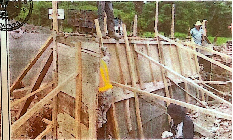
CONSTRUCCIÓN DE CAJA PUENTE EN CRUCE DE QUEBRADA ENTRE LAS COMUNIT EL TESORO Y LAS FLORES, EN EL MUNICIPIO DE EL PARAISO COPAN
