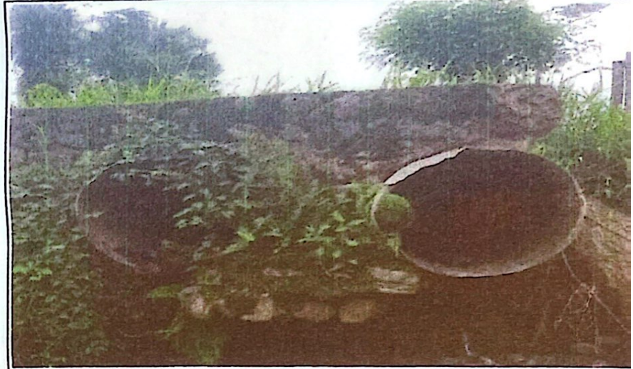
CONSTRUCCIÓN DE CAJA PUENTE EN CRUCE DE QUEBRADA ENTRE LAS COMUNIDADES DE EL TESORO Y FLORES, EN EL MUNICIPIO DE EL PARAISO COPAN
