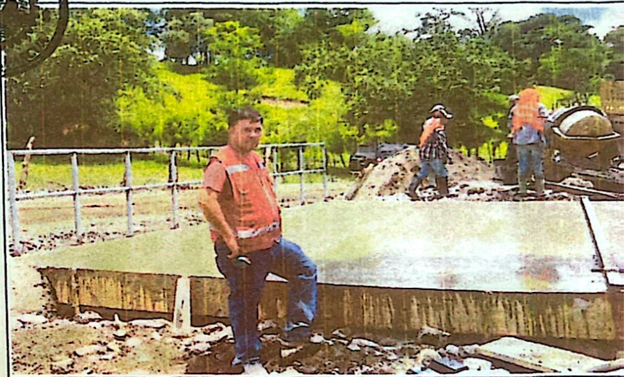
CONSTRUCCIÓN DE CAJA PUENTE EN CRUCE DE QUEBRADA ENTRE LAS COMUNIDADES TESORO Y LAS FLORES, EN EL MUNICIPIO DE EL PARAISO COPAN
