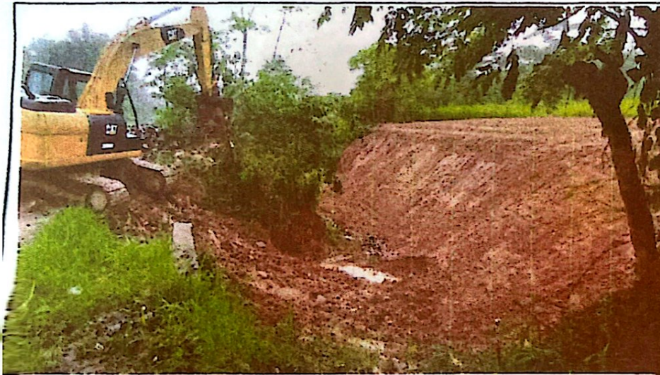
CONSTRUCCIÓN DE CAJA PUENTE EN CRUCE DE QUEBRADA ENTRE LAS COMUNIDADES DE EL TESORO Y FLORES, EN EL MUNICIPIO DE EL PARAISO COPAN
