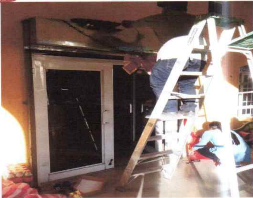
Elaboración E Instalación Cortina De Metal Para Protección Y Seguridad En Las Puerta Alcaldía Municipal
