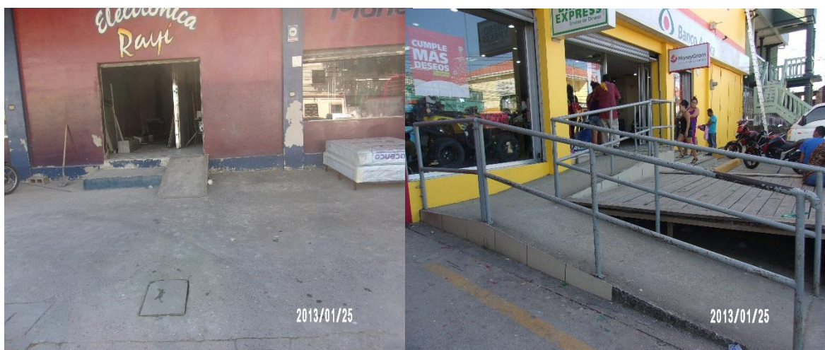
Ilustración 2 Acceso de rampa a empresas
