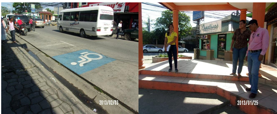
Ilustración 1 Inspección construcción de rampa a empresas
