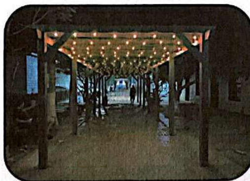
Reparacion de faroles y bajada electrica 2da pergola
