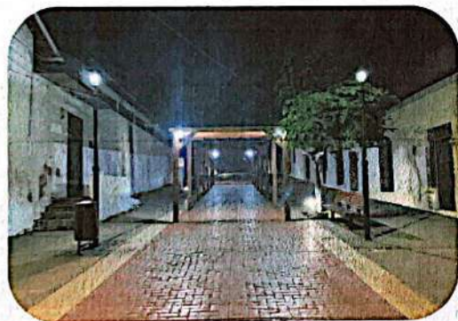
Instalacion de lamparas led en 3ra pergola
