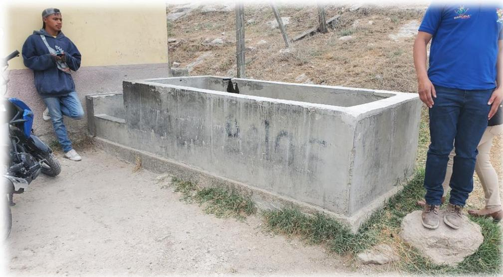
Pila a demoler por fisuras en los 4 lados.
