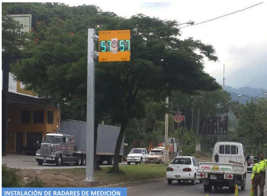
INSTALACIÓN DE RADARES DE MEDICIÓN
