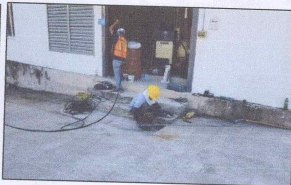
Instalación de cableado eléctrico para generadores auxiliares
