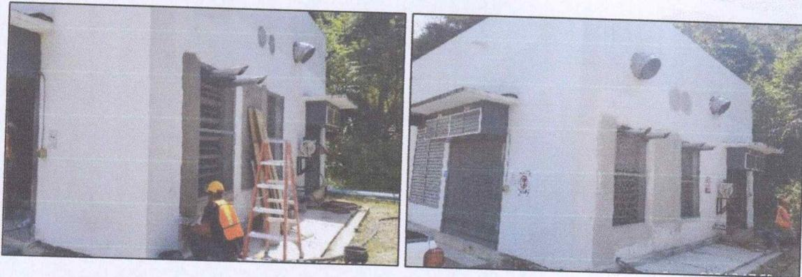
Trabajos de repello en pared donde se efectuó modificaciones para instalación de nuevos Generadores.
