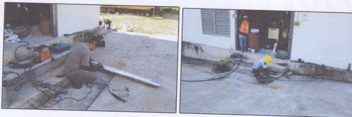
Soldadura para tubería de escape de Generadores Auxiliares.
