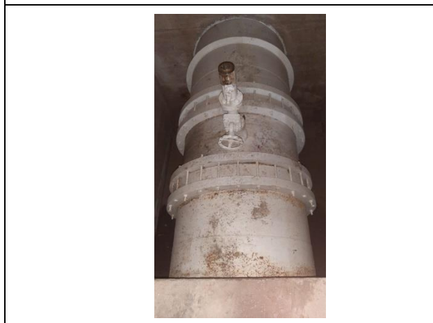
Penstock No. 1 de la C.H. Río Lindo (Juntas de montaje tipo dresser Túnel de aire forzado) Unidad 1
