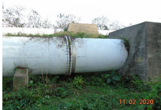
Penstock No. 2 de la C.H. Río Lindo (Junta de expansión No.15 entre los soportes 1408 y 1409)
