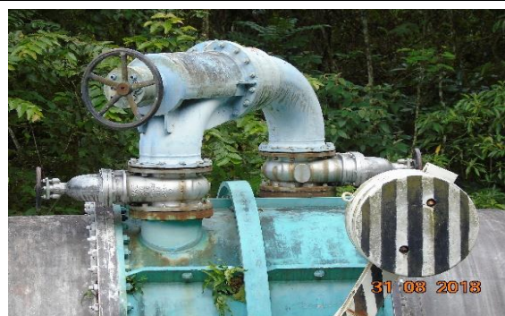
Palanca Operada con Contrapeso No. 1
