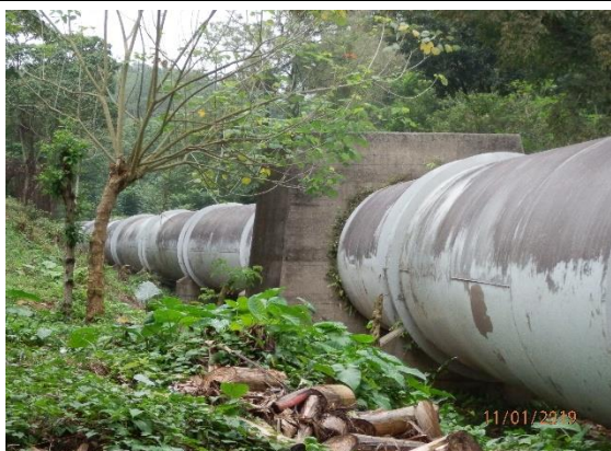
Tubería Aguas Arriba No. 1 para la Central Hidroeléctrica Río Lindo (Anclaje FP1)
