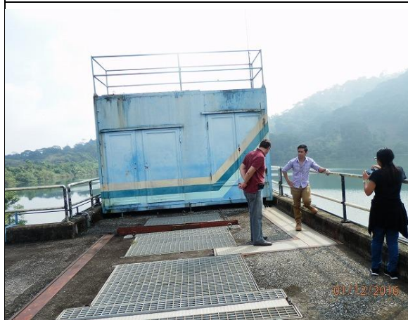
Estructura de Bocatoma de Río Lindo Guías Embebidas de rejilla coladora de bocatoma
