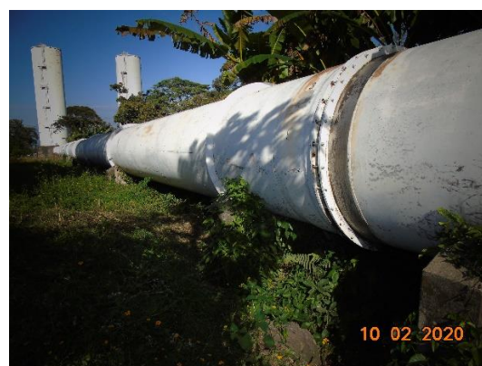
Tubería Presurizada No. 2 de la C.H. Río Lindo (Junta de expansión No.3 entre los soportes 213 y 214)
