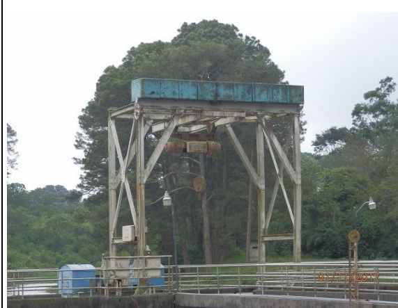
Estructura de Bocatoma de Cañaveral Polipasto para compuerta de bocatoma
