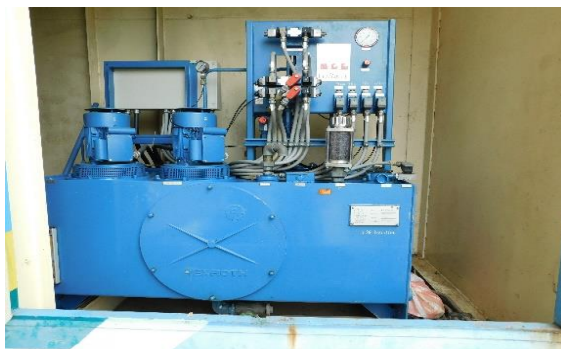
Compuertas de Bocatoma de Río Lindo (Equipo Hidráulico)
