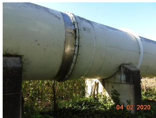
Penstock No. 1 de la C.H. Río Lindo (Junta de expansión No. 10 entre los soportes 900 y 901)
