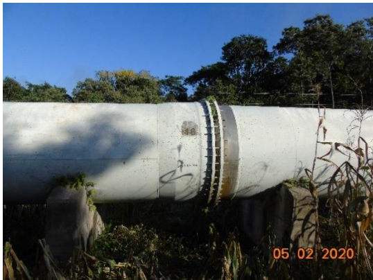
Penstock No. 2 de la C.H. Río Lindo (Junta de expansión No.16 entre los soportes 1504 y 1505)
