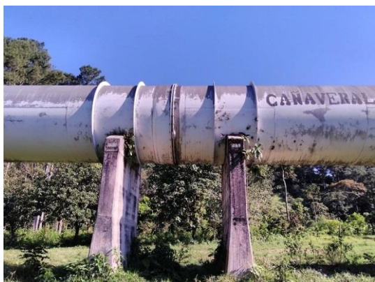
Junta de montaje ( dresser )
