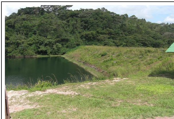
Presa de Yure (Cuerpo de la presa vista desde aguas-abajo)
