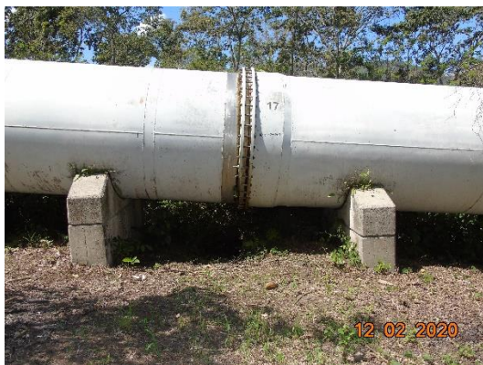
Penstock No. 1 de la C.H. Río Lindo (Junta de expansión No.17 entre los soportes 1608 y 1609)
