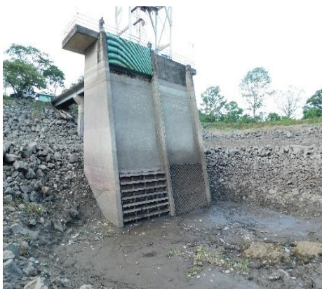
Compuerta de Bocatoma de Cañaverl (Cuerpo de Compuerta)
