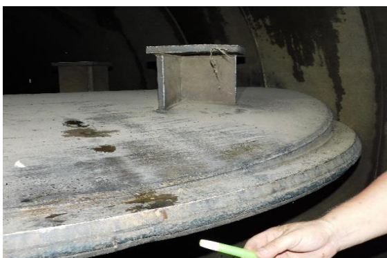
El lapiz señala el empaque del disco de la válvula
