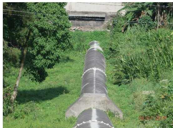
Penstock de la Central Hidroeléctrica Cañaverl (Vista desde el anclaje No.3, se aprecia la Casa de Máquinas al fondo)
