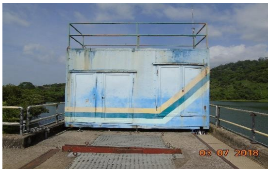
Compuertas de Bocatoma de Río Lindo (Gabinete Pre-fabricada, para Exteriores)
