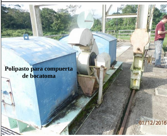
Estructura de Bocatoma de Cañaveral Polipasto para compuerta de bocatoma
