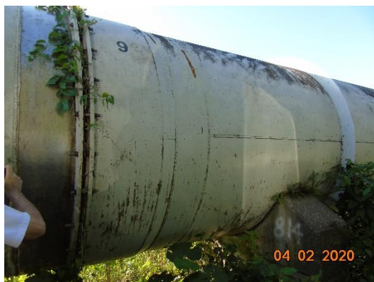
Penstock No. 1 de la C.H. Río Lindo (Junta de expansión No. 11 entre los soportes 1021 y 1022)
