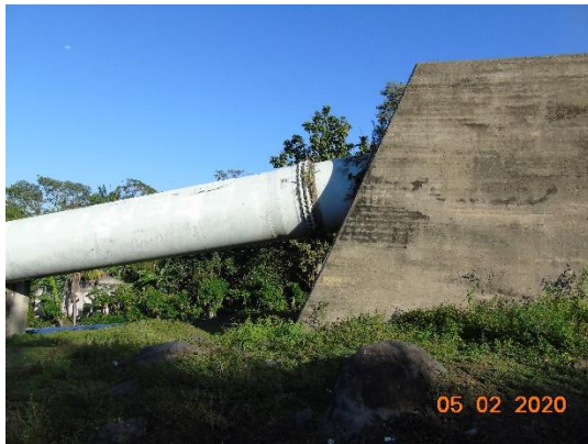
Penstock No. 2 de la C.H. Río Lindo (Junta de expansión No.17 entre los soportes 1600 y 1601)
