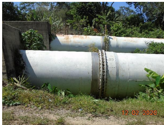
Penstock No. 1 de la C.H. Río Lindo (Junta de expansión No.22 entre los soportes 2100 y 2101)
