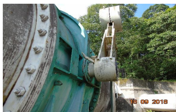
Palanca Operada con Contrapeso No. 1
