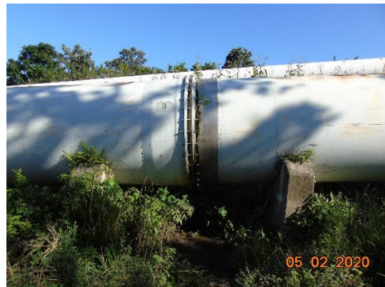
Penstock No. 2 de la C.H. Río Lindo (Junta de expansión No.9 entre los soportes 808 y 809)
