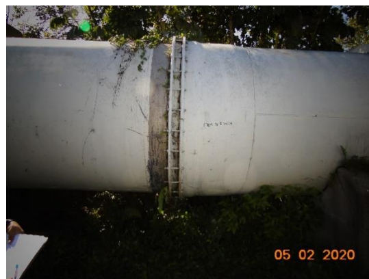
Penstock No. 2 de la C.H. Río Lindo (Junta de expansión No.9 entre los soportes 808 y 809)
