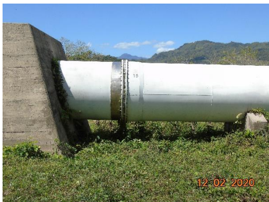
Penstock No. 1 de la C.H. Río Lindo (Junta de expansión No.17 entre los soportes 1608 y 1609)
