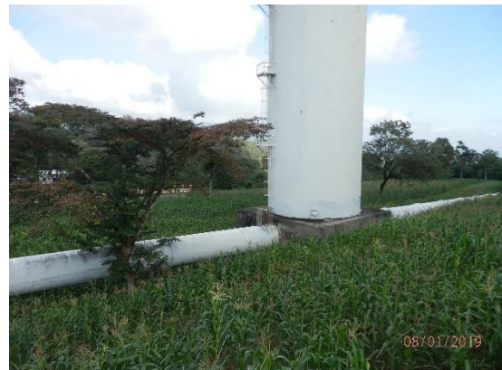
(9) Penstocks No. 1 y No. 2 de la Central Hidroeléctrica Río Lindo
