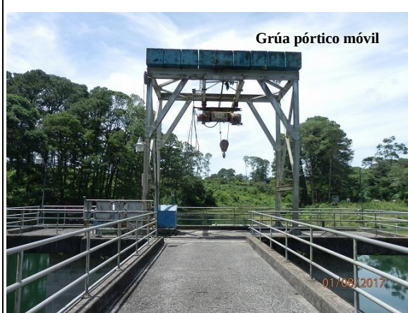
Estructura de Bocatoma de Cañaveral Polipasto para compuerta de bocatoma
