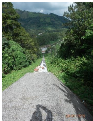
Penstock de la Central Hidroeléctrica Cañaverl (Llegada del penstock a la Casa de
