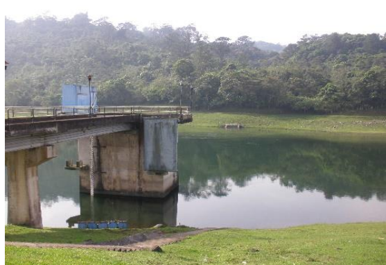
Estructura de Bocatoma de Río Lindo (Estructura del Puente y Pasamanos)
