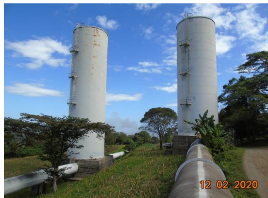
A la izquierda: Penstock No.2 anclaje FP10 y a la derecha: Penstock No.1 anclaje FP12
