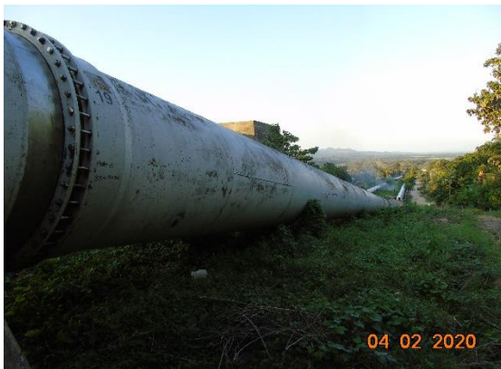
Penstock No. 1 de la C.H. Río Lindo (Junta de expansión No.21 entre los soportes 2017 y 2018)
