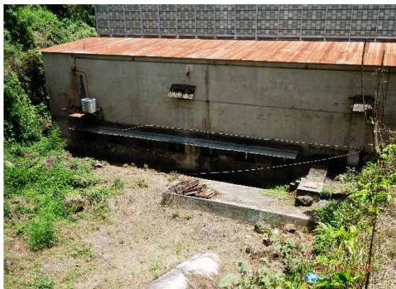
(7) Tubería Aguas Arriba No. 1 para la Central Hidroeléctrica Río Lindo
