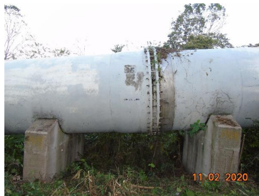
Penstock No. 2 de la C.H. Río Lindo (Junta de expansión No.15 entre los soportes 1408 y 1409)
