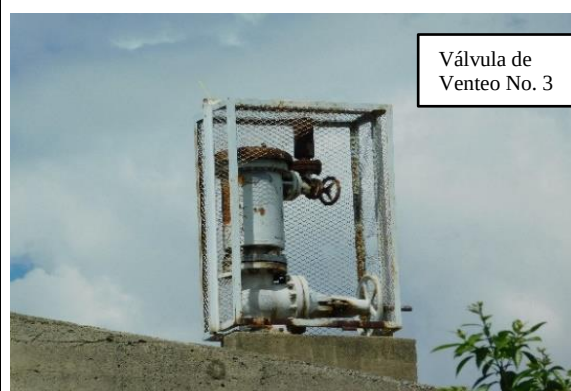
Válvula de Venteo No. 3 en el Segmento 1500
