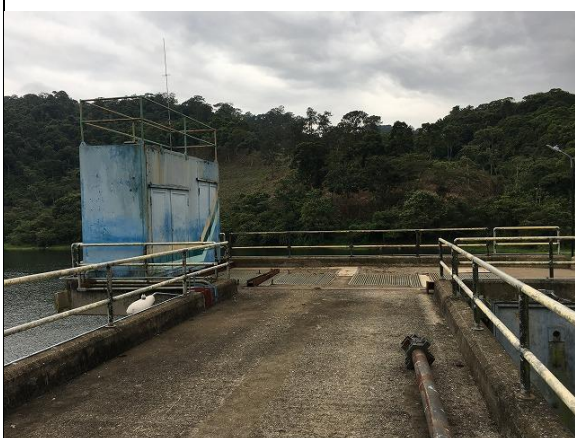
Estructura de Bocatoma de Río Lindo Puente de acceso (Ancho=4m)
