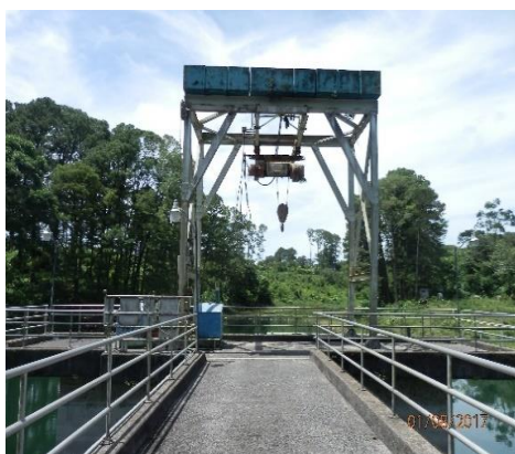
Estructura de Bocatoma de Cañaverl (Grúa Móvil Tipo Pórtico)
