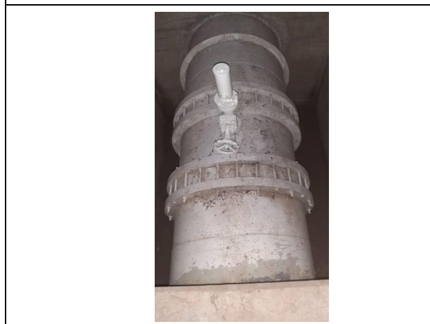
Penstock No. 1 de la C.H. Río Lindo (Junta de montaje tipo dresser túnel de aire forzado) Unidad 2
