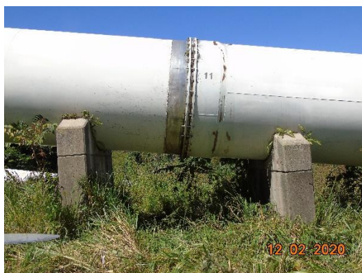
Penstock No. 1 de la C.H. Río Lindo (Junta de expansión No. 11 entre los soportes 1021 y 1022)
