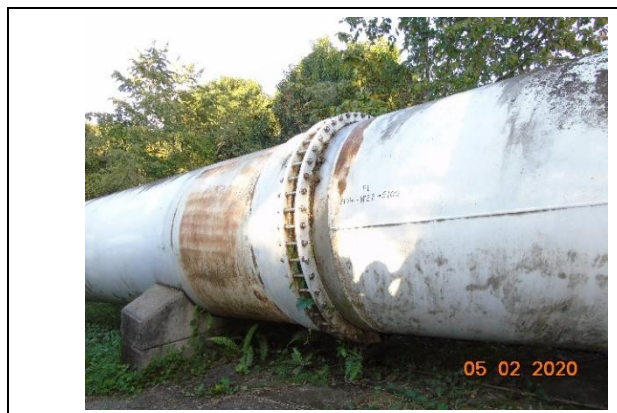
Penstock No. 1 de la C.H. Río Lindo (Junta de montaje tipo dresser túnel de aire forzado) Unidad 2
