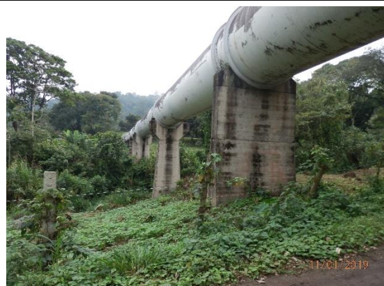
Tubería Aguas Arriba No. 1 para la Central Hidroeléctrica Río Lindo (Soportes de Concreto)
