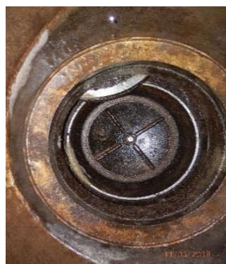
Válvula de venteo en Posición Cerrada
