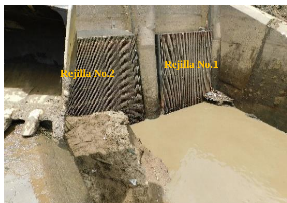
Estructura de Bocatoma de Río Lindo Rejillas coladoras de bocatoma de Río Lindo
