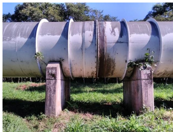
(Junta de expansión No.4, entre los soportes 313 y 314)
