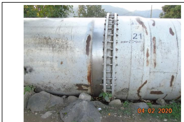
Penstock No. 1 de la C.H. Río Lindo (Juntas de montaje tipo dresser Túnel de aire forzado) Unidad 1
