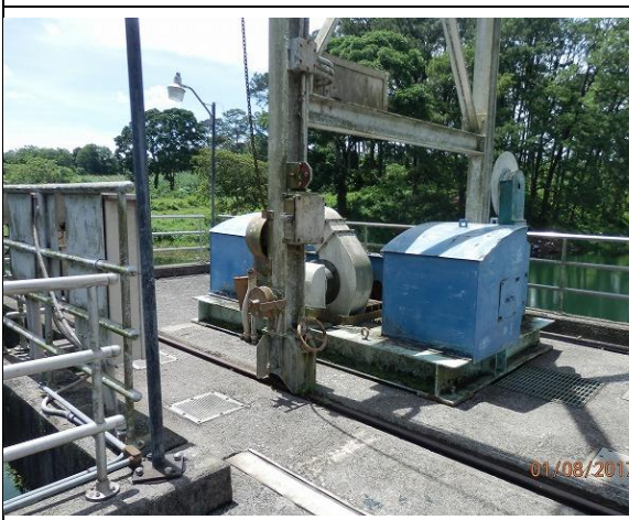
Estructura de Bocatoma de Cañaveral Polipasto para compuerta de bocatoma
