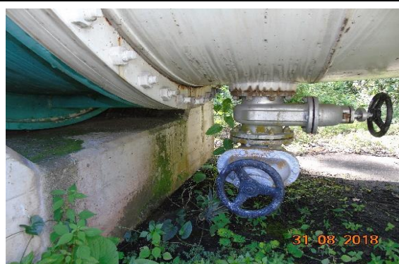
Válvulas de Drenaje No. 1
