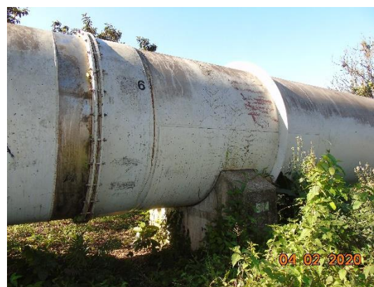
Tubería Presurizada No. 1 de la C.H. Río Lindo (Junta de expansión No.6 entre los soportes 513 y 514)
