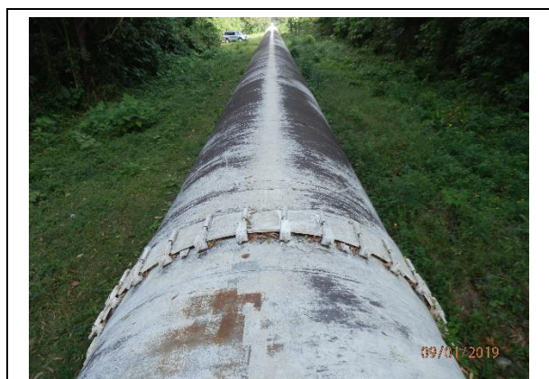
Penstock de la Central Hidroeléctrica Cañaverl (Anclaje de Concreto No.2 vista hacia Punto Alto)
