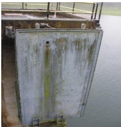
Estructura de Bocatoma de Río Lindo (Mampara y Pasamanos)
