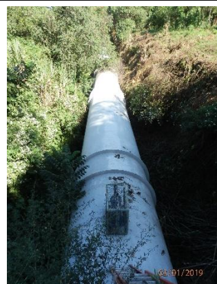
Tubería Aguas Arriba No. 1 para la Central Hidroeléctrica Río Lindo (Soportes de Concreto)
