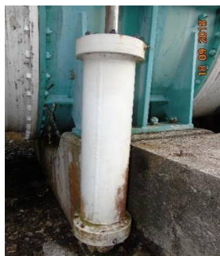
Válvula de venteo en Posición Cerrada
