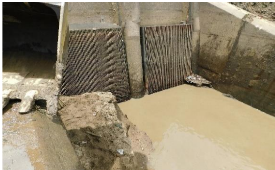
Estructura de Bocatoma de Río Lindo (Mampara y Pasamanos)
