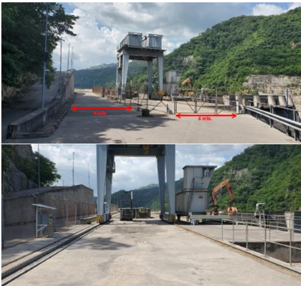
Vista Grúa de Pórtico
