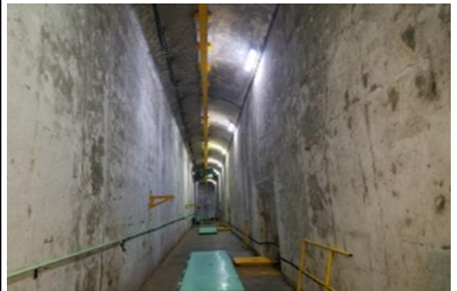
Vista General de la Instalación de la Grúa.
