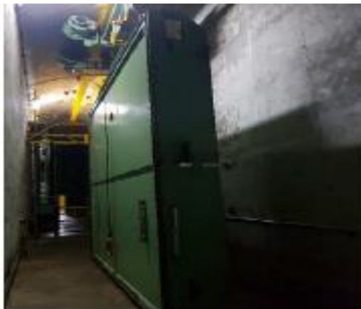
Vista de la Grúa Descarga de Turbina, soportando una Ataguía
