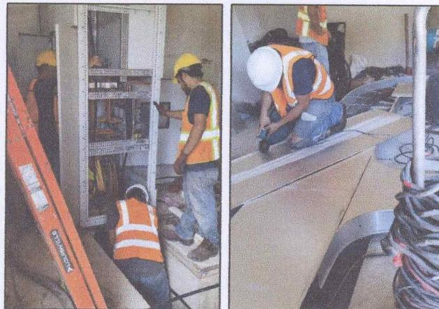
Instalación de cableado y colocación de bandejas protectoras en adecuaciones del BSA de Honduras.
