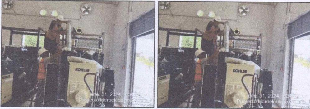
Trabajos de soldadura e instalación de tubería para los escapes de los generadores.
