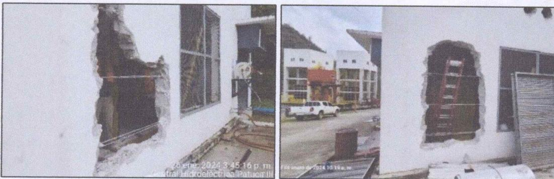
Apertura de boquete en pared para instalación de ductos de ventilación de generadores auxiliares.
