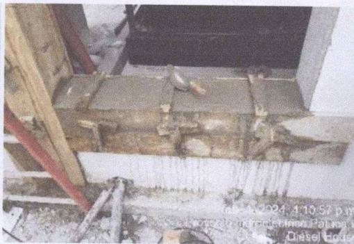
**Proceso de fundición y acabado final de vigas y columnas para adecuación del Diesel House.**
