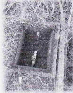
*Fotografía II " Caja de Registro deterioradas en Viviendas"*
