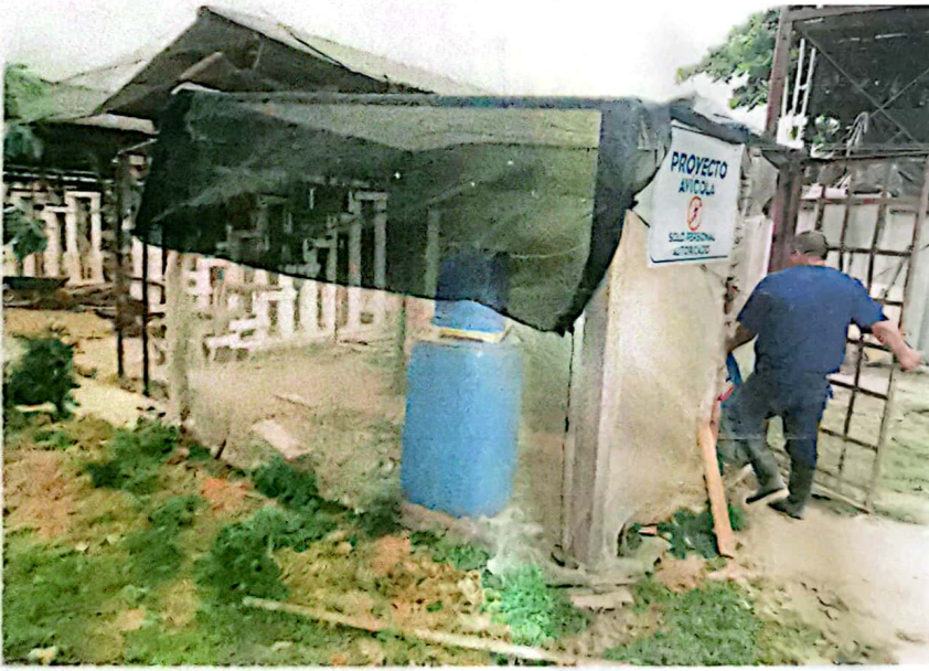
Actual túnel de desinfección, en el próximo mes se realizaran sus mejoras.
