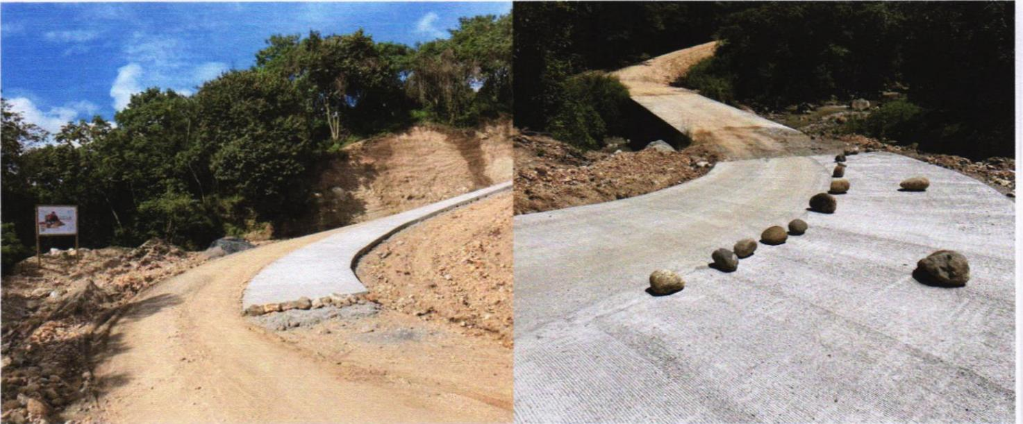
*Fundición de tramo de 40.00 metros de pavimento con concreto ciclópeo.*
