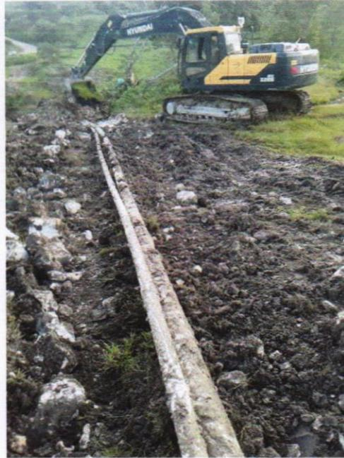
*Aterrado de tramos de tubería en Línea de Conducción de Rio Hondo.*
