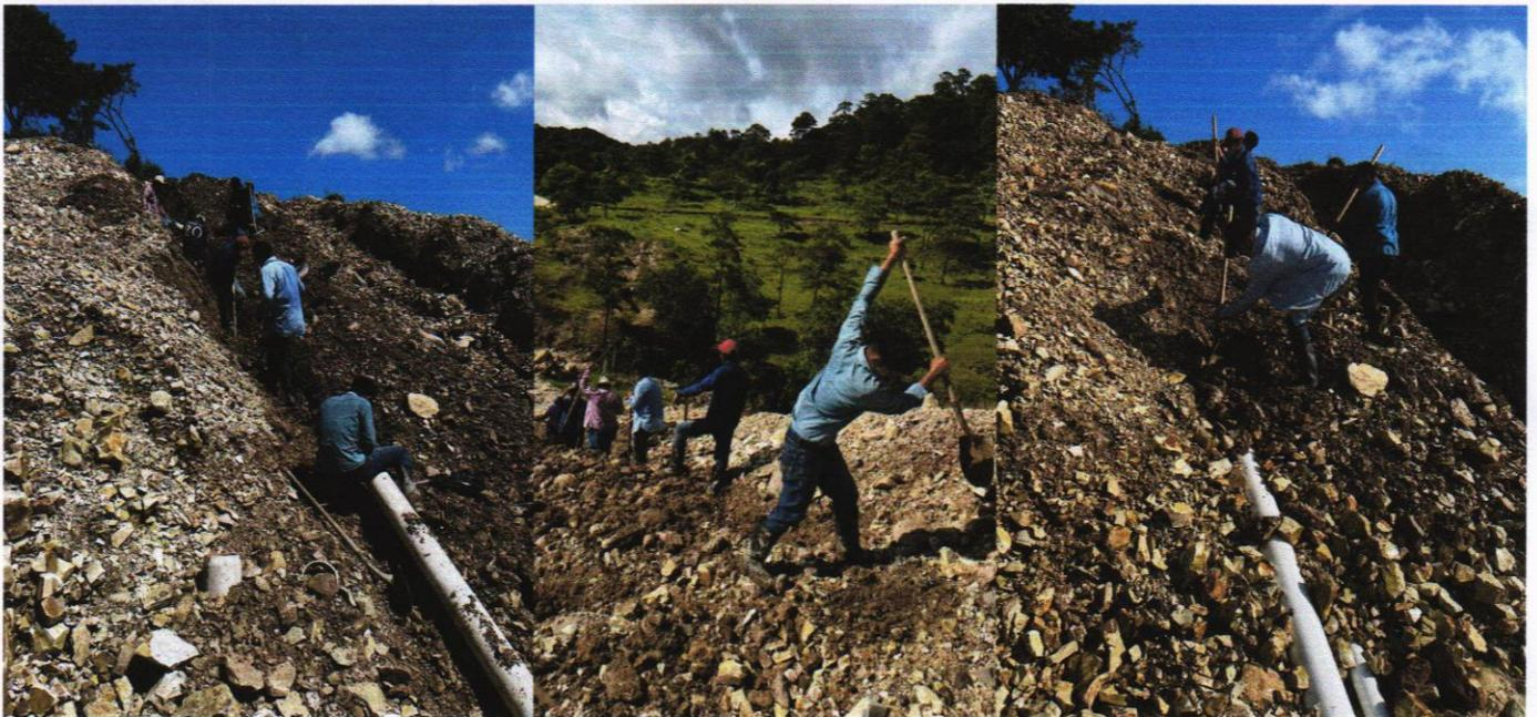
*Reparación de fugas y fallas de tubería en Línea de Conducción de Rio Hondo.*
