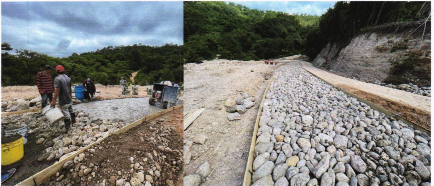
*Fundición de tramo de pavimento con concreto ciclópeo.*
