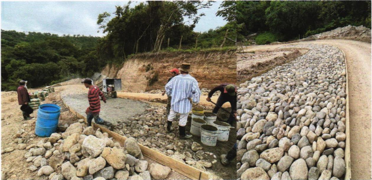
*Encofrado y colocación de piedra para fundición de pavimento con concreto ciclópeo.*
