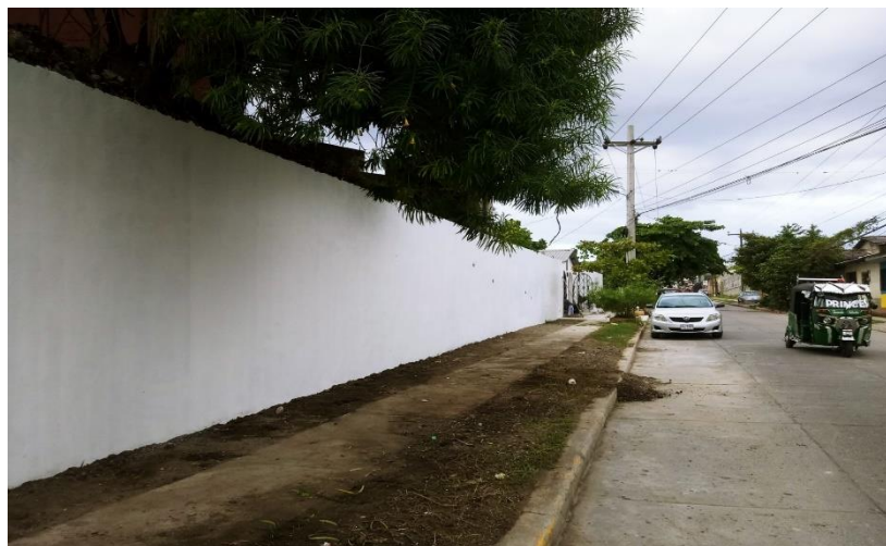
Resanes, repello, pulido y aplicación de pintura en parte frontal del cerco perimetral y entrada principal de cementerio municipal.
