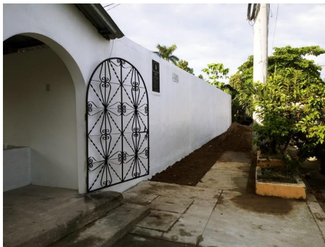
Resanes, repello, pulido y aplicación de pintura en parte frontal del cerco perimetral y entrada principal de cementerio municipal.
