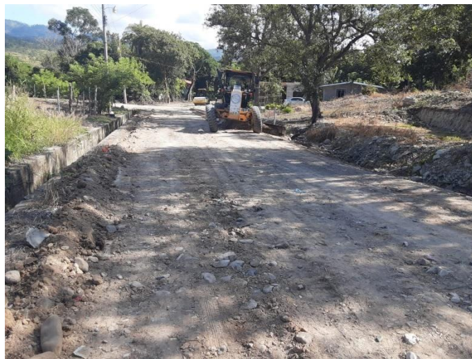
Trabajos de escarificado, conformación, cuneteo y vibrado de calles de colonia Villa Marlen.
