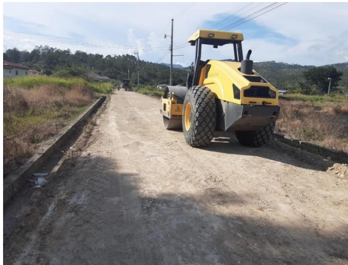
Trabajos de escarificado, conformación, cuneteo y vibrado de calles de colonia Villa Marlen.
