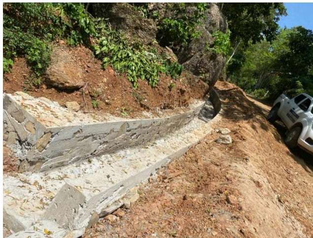
Actividad de caminos productivos proyecto Rehabilitación camino tramo El Zanjón – San Marcos, Nueva Arcadia, Copán.
