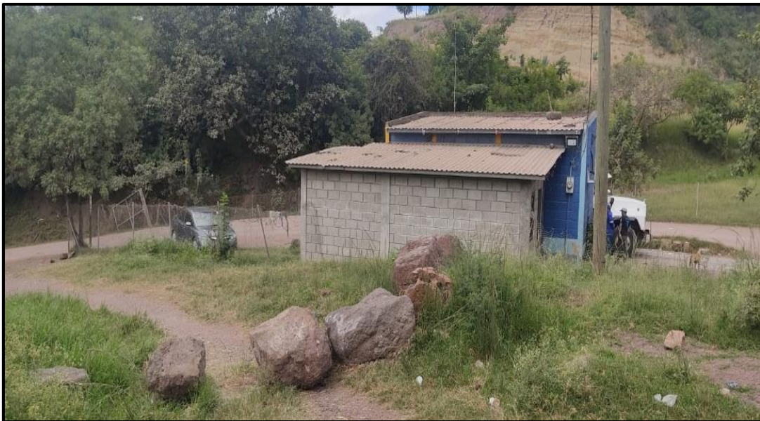
Sitio del emplazamiento de la nueva bascula
