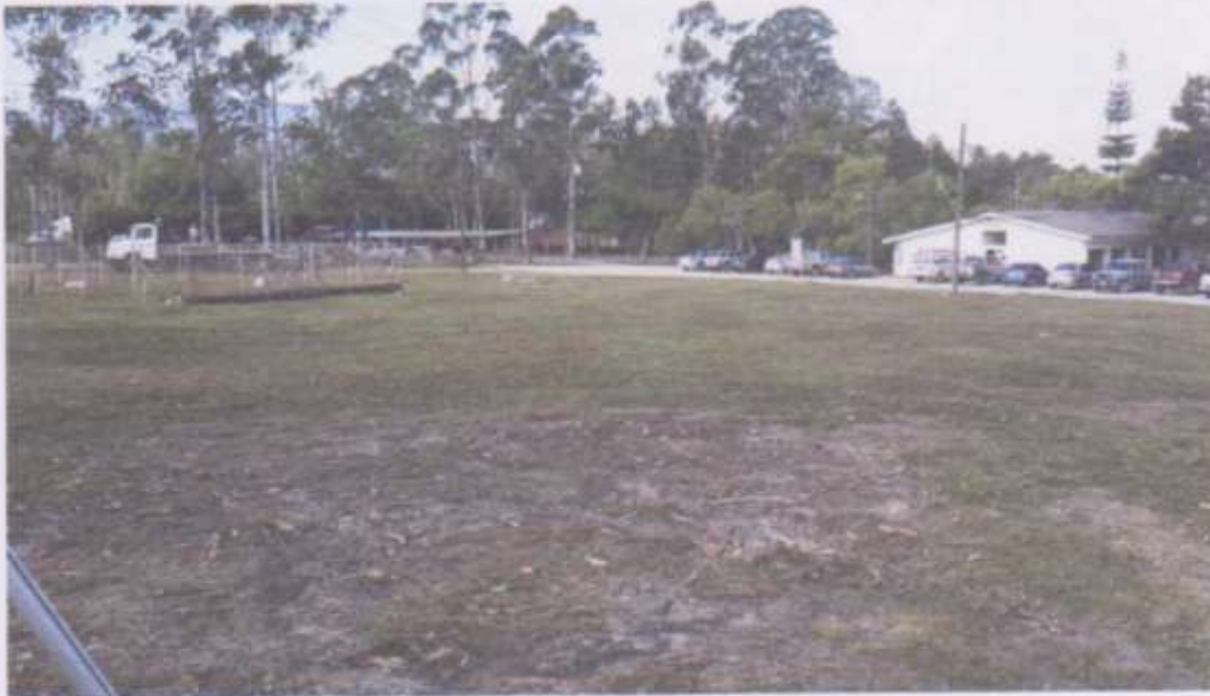
Estado Inicial del Terreno en el que se construye el Proyecto
