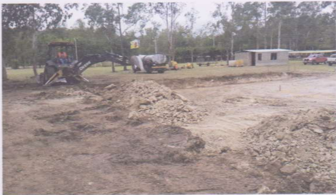
Corte según perfil topográfico.
