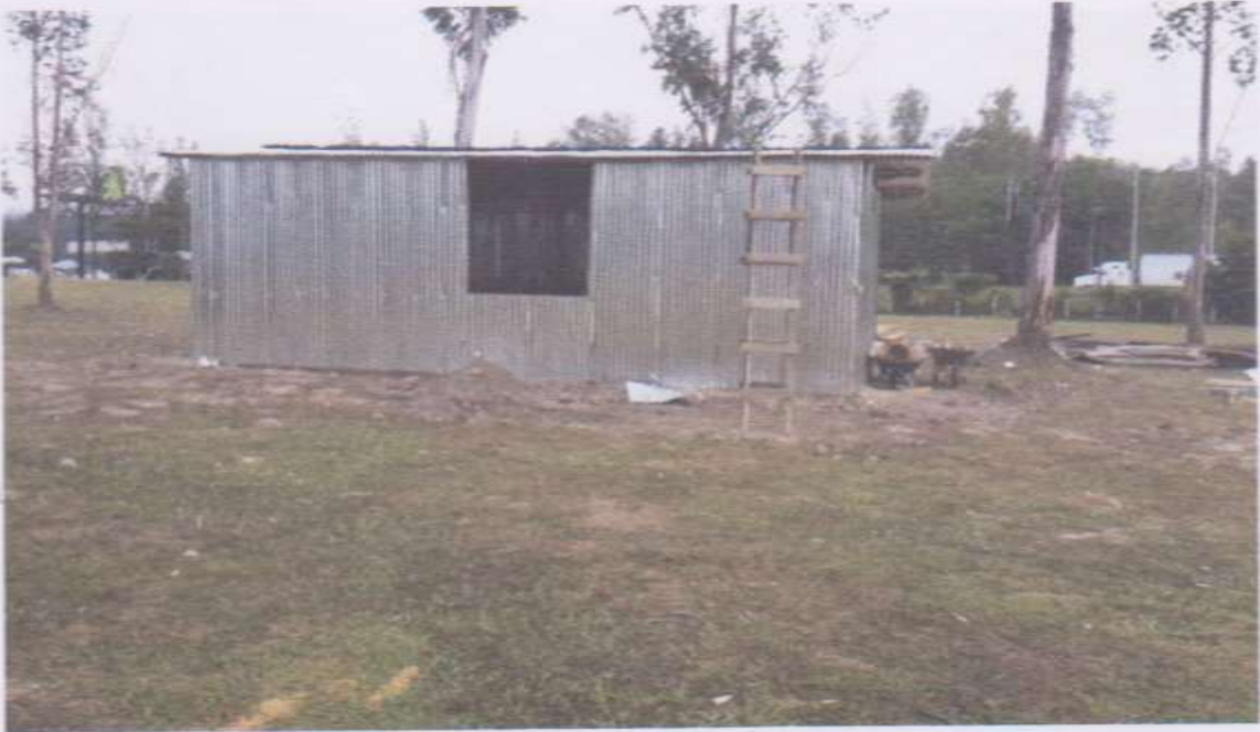
Construcción de Bodega para Materiales
