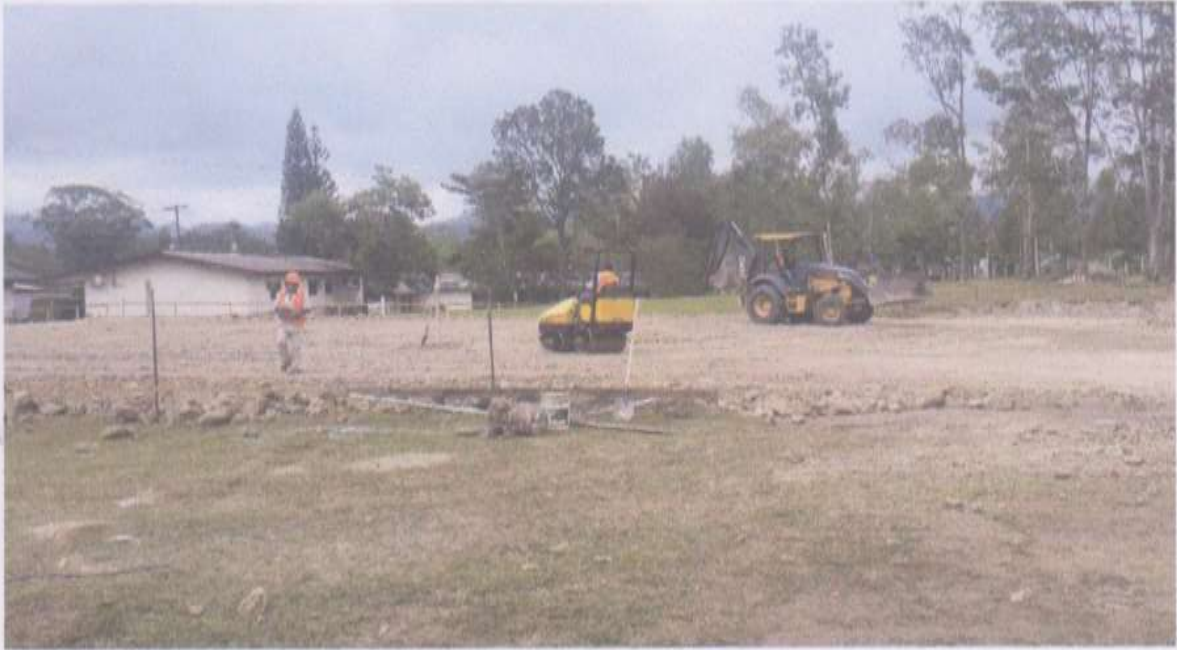
Relleno y compactación del terreno.
