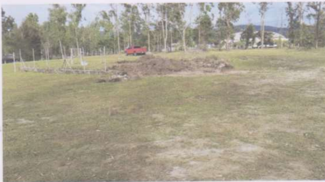
Demolición de Plantel Antigua Estación de Meteorología
