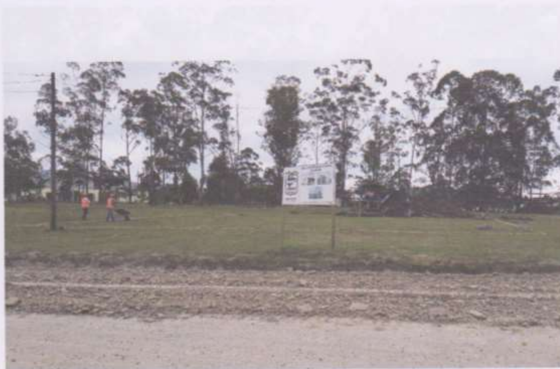
Marcado para Posicionamiento del Edificio
