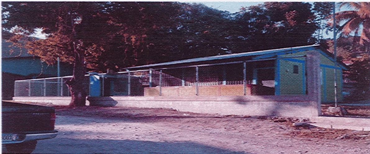
Construcción de Cerco Perimetral del Kínder de la Cruz Roja
