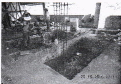
Relleno y compactado de zapatas
