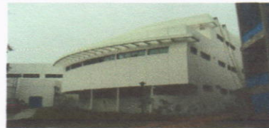
Fachada Sur, Modulo D
