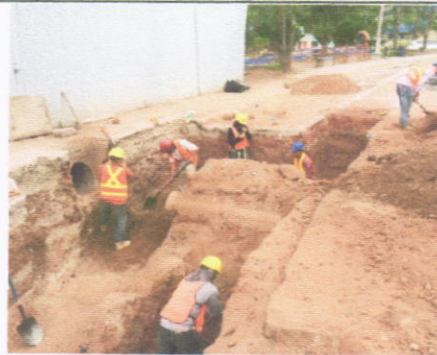
Excavación de zanjas para instalación de sistema de aguas lluvias.
