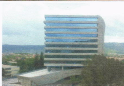
Vista sur-este del edificio.
