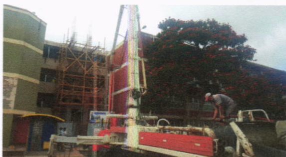
Vista de fundición de paredes en cubo de elevador edificio D1
