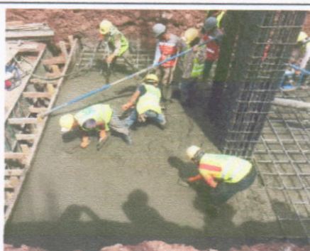
Fundición de zapatas.
