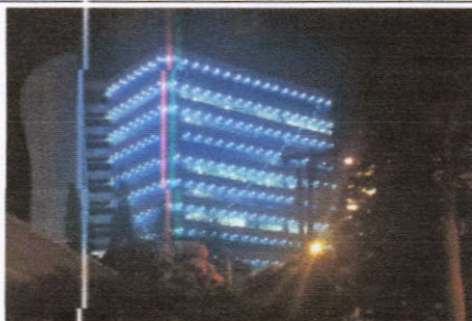
Vista oeste del edificio.
