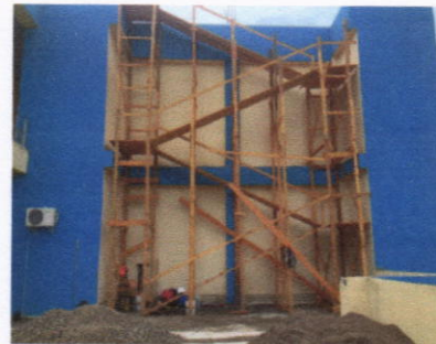
Rampa construida para el acceso de personal a azotea No. 2
