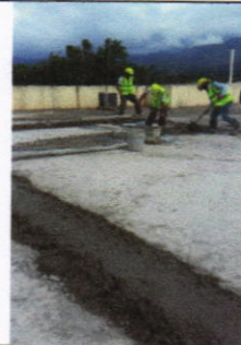
Fundición de pañuelos de nivelación
