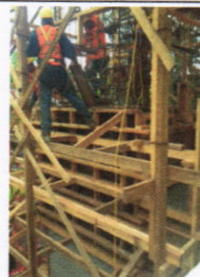
Vista de encofrado para cubo de elevador, se agregaron anillos de madera para refuerzo
