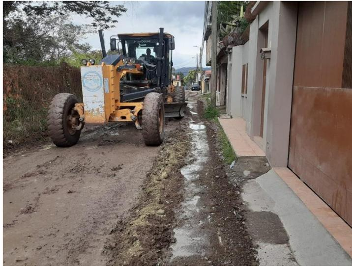
Se observa la máquina realizando trabajo de escarificado, conformación, cuneteo y vibrado en calles del barrio Miraflores.
