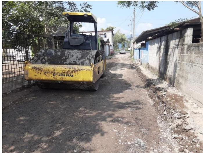
Se observa la maquinaria municipal realizando trabajos de escarificado, conformación, cuneteo y vibrado en calles de la colonia Juan Benito Montoya.
