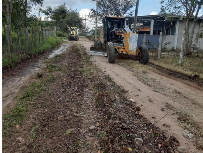
Se observa la máquina realizando trabajo de escarificado, conformación, cuneteo y vibrado en calles de la colonia Miravalle 2.
