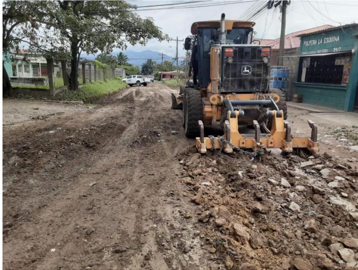
Se observa la máquina realizando trabajo de escarificado, conformación, cuneteo y vibrado en calles del barrio El Dorado.
