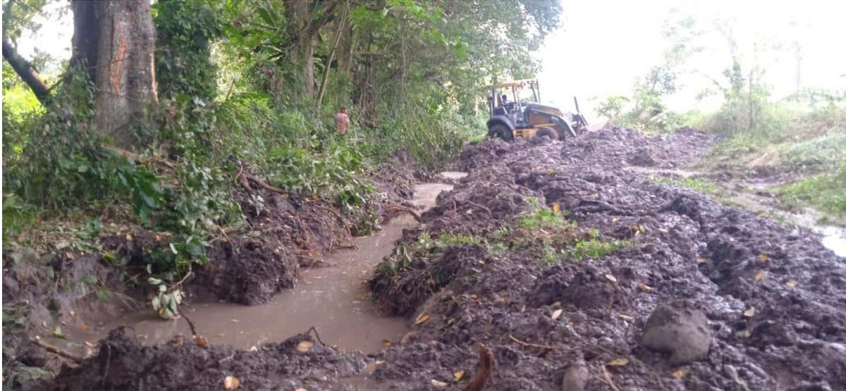
Se observa la maquinaria municipal en trabajos de excavación para posteriormente reparación de tubo de agua potable de la línea de conducción de Rio Chiquito hacia La Entrada.
