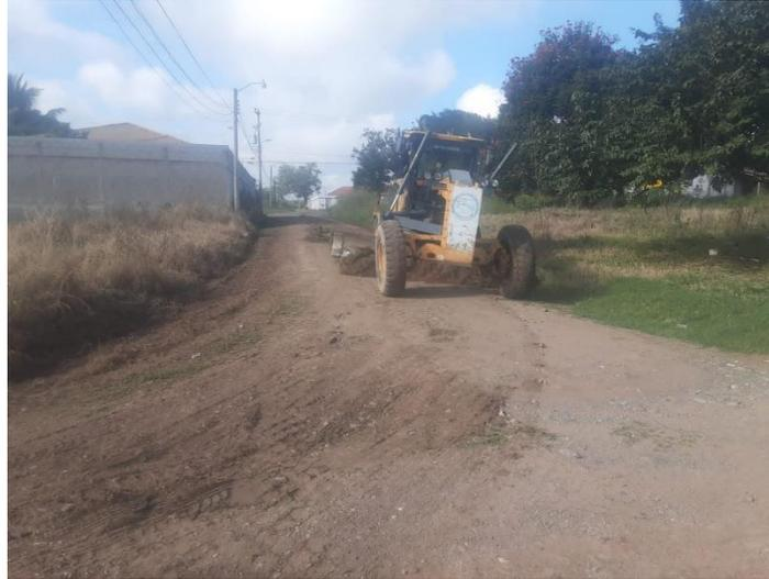
Se aprecia la maquinaria municipal en trabajo de escarificado, conformación, cuneteo y vibrado en calles de la colonia Miravalle.
