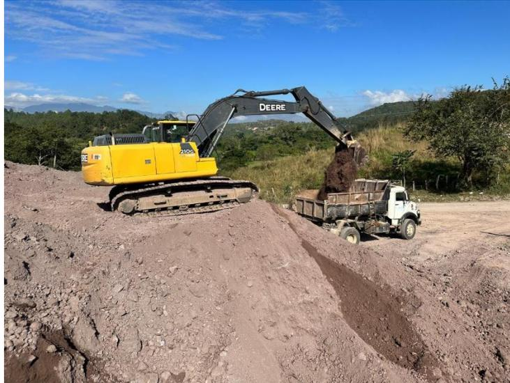
Se observa la máquina realizando trabajo de corte de material selecto en aldea Los Pozos para balastado en calles de la colonia Miravalle 2.
