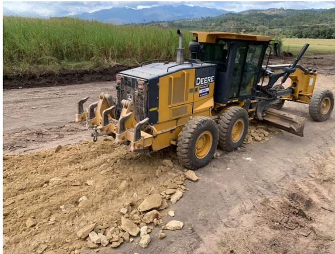
Se observa la máquina municipal realizando trabajo de escarificado, conformación, cuneteo y vibrado en calle que conduce de la colonia Miravalle a MECFER.
