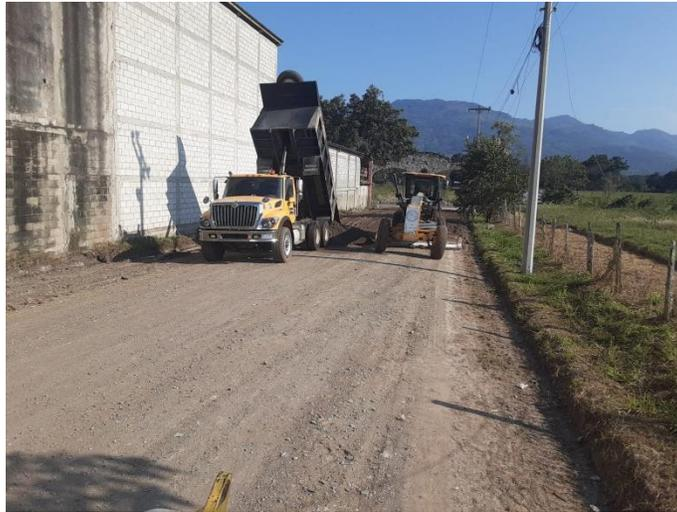
Se observa la maquinaria municipal realizando trabajos de escarificado, conformación, cuneteo y vibrado en calles de la colonia María Antonieta.
