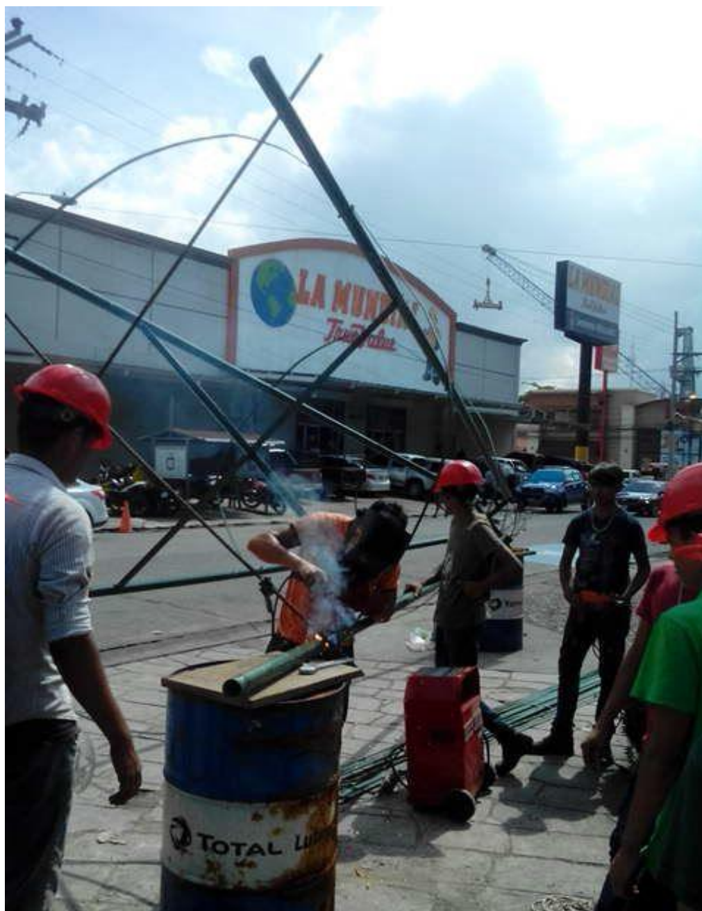
5Elaboracion de estructuras metalica
