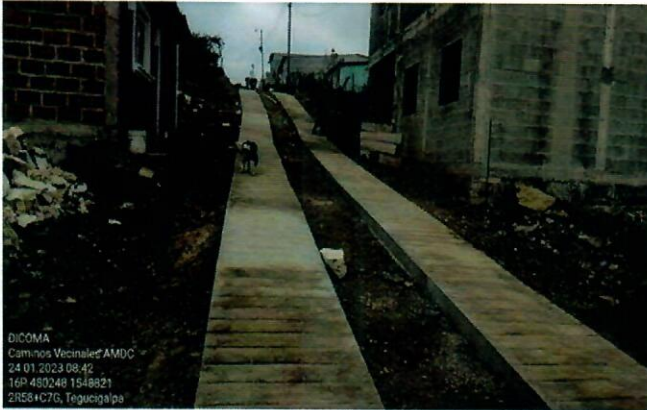
Huellas Vehiculares de concreto Hidraulico, Colinas de Santa Rosa
