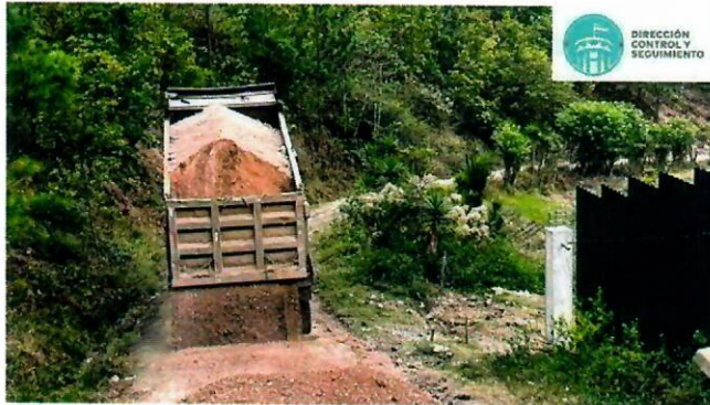
Conformación y balastado de calles, Tramo del Piligüin
