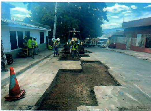
Colocación de Asfalto, calle Paseo Casamata
