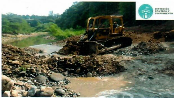
Dragado, limpieza y canalización del Rio Grande, tramo Barrio la bolsa
