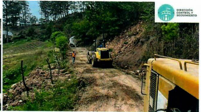
Conformación y balastado de calles, Tramo del Piligüin
