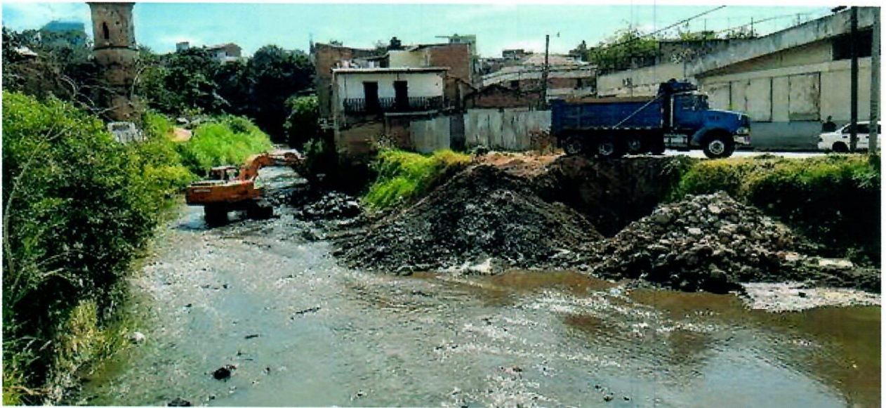
Dragado y canalización Río Chiquito, sector Barrio la Hoya
