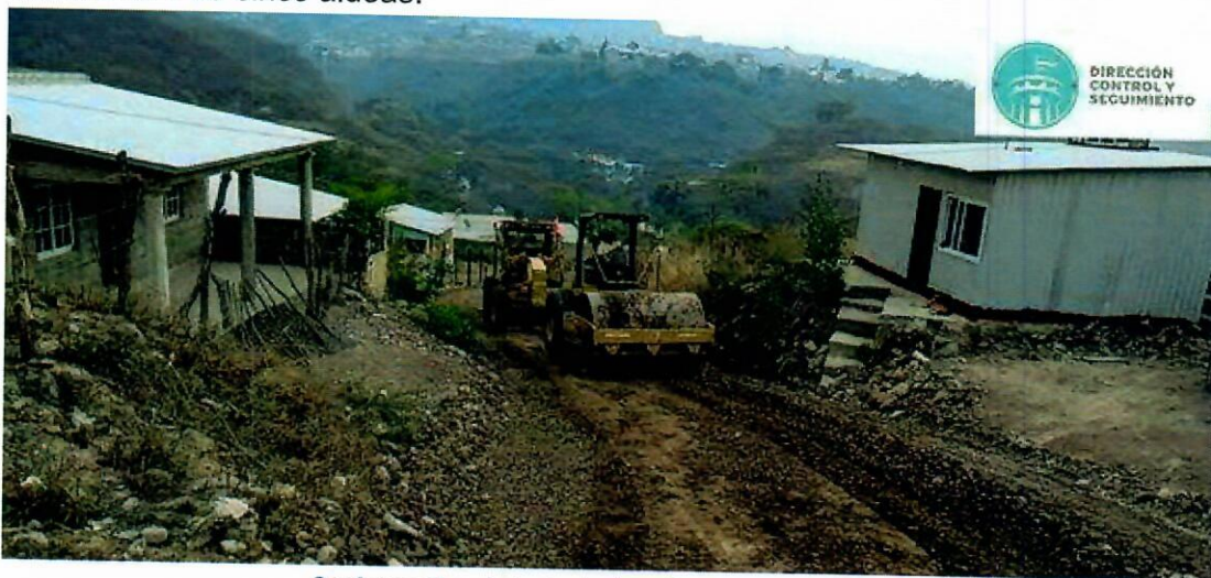
Conformación y balastrado de calles, Aldea Santa Rosa
