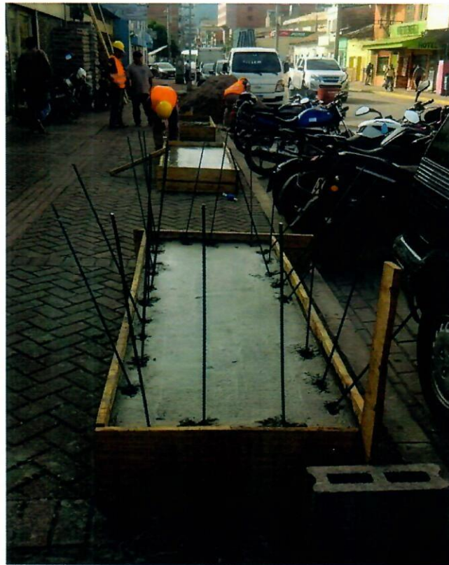
Recuperación Avenida Gutenberg
