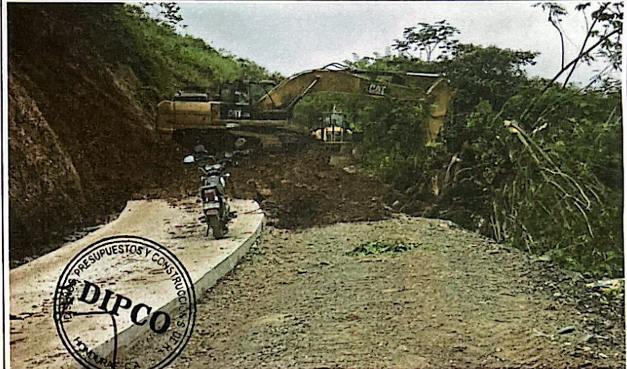
REMOCION DE DERRUMBES, BACHEO O RELLENO CON MATERIA DE RIO TIPO CASCAJO, EN PASOS DAÑADOS POR LLUVIAS, EN TRAMO CARRETERO, EL PARAISO - LA LAGUNA, EN EL MUNICIPIO DE EL PARAISO COPAN
