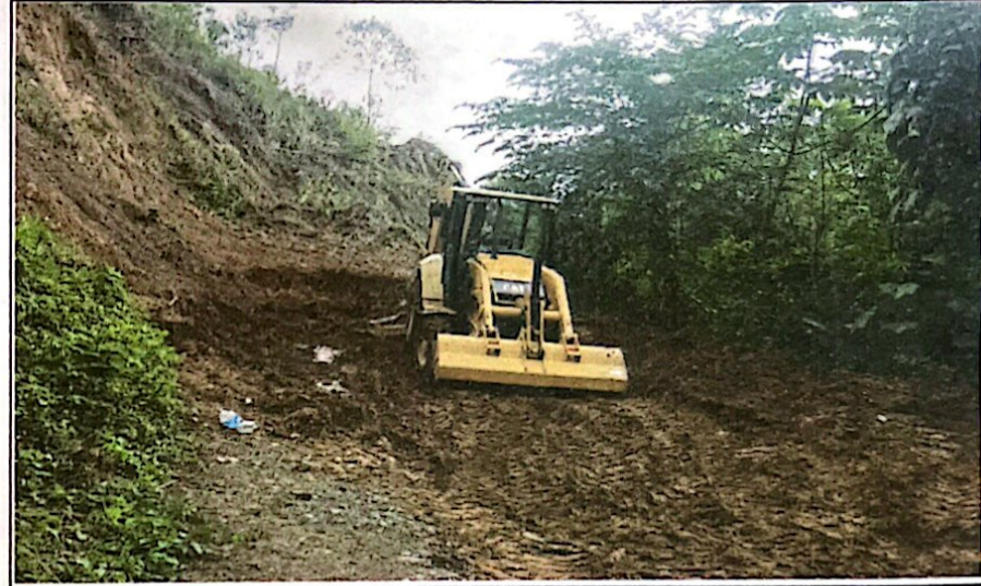
REMOCION DE DERRUMBES, BACHEO O RELLENO CON MATERIA DE RIO TIPO CASCAJO, EN PASOS DAÑADOS POR LLUVIAS, EN TRAMO CARRETERO, EL PARAISO - LA LAGUNA, EN EL MUNICIPIO DE EL PARAISO COPAN
