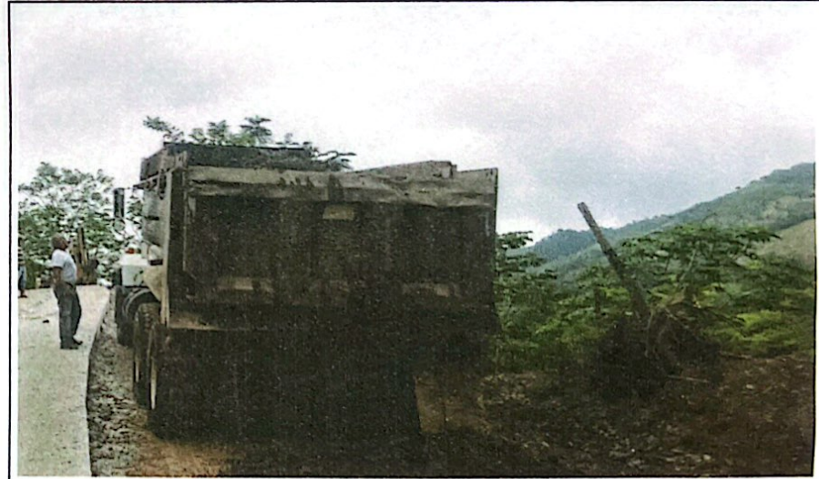
REMOCION DE DERRUMBES, BACHEO O RELLENO CON MATERIA DE RIO TIPO CASCAJO, EN PASOS DAÑADOS POR LLUVIAS, EN TRAMO CARRETERO, EL PARAISO - LA LAGUNA, EN EL MUNICIPIO DE EL PARAISO COPAN
