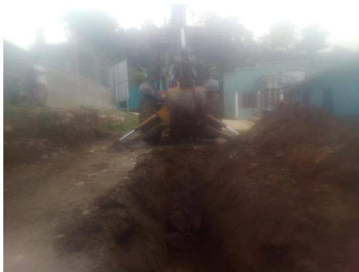
Se aprecia la excavación para instalación de tubería para alcantarillado de aguas residuales en aldea de Quebrada Seca.
