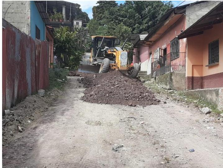
Se observa la maquinaria municipal realizando trabajos de escarificado, conformación, cuneteo y vibrado en calles del barrio Morazán.
