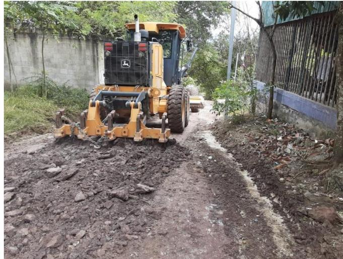
Se observa la maquinaria municipal realizando trabajo de escarificado, conformación, cuneteo y vibrado en calles del barrio Bella Vista.
