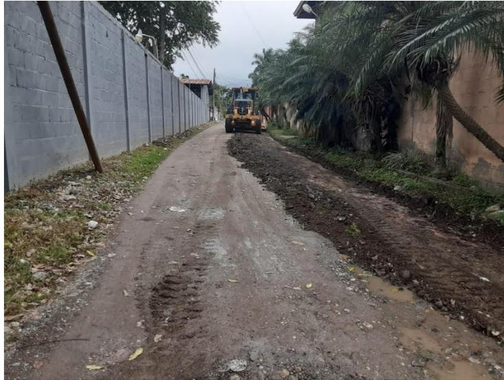
Se observa la máquina realizando trabajo de escarificado, conformación, cuneteo y vibrado en calles de Col. Miravalle.
