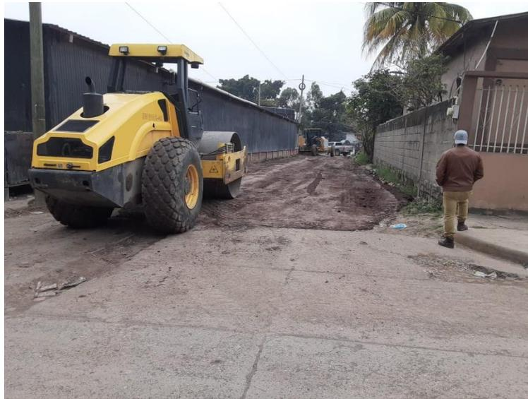
Se observa la maquinaria municipal realizando trabajo de escarificado, conformación, cuneteo y vibrado en calles del barrio El Banco.
