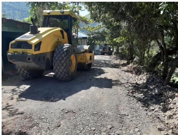
Se aprecia la maquinaria municipal en trabajo de escarificado, conformación, cuneteo y vibrado en calles del barrio Suyapa.
