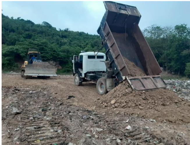
Trabajo de acarreo de material selecto para soterramiento de basura en el relleno sanitario.
