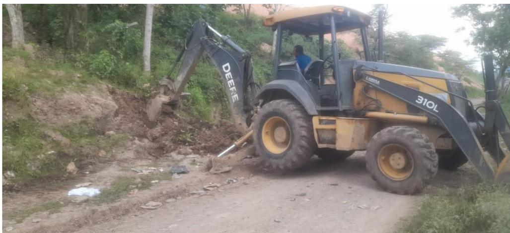
Se observa la máquina municipal realizando trabajo de apoyo en excavación para mantenimiento de tubería de agua potable en aldea San Pablo del Roble.
