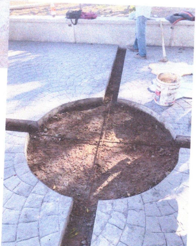
3. En la próxima foto se muestra el incremento de relleno compactó para base del estampado
