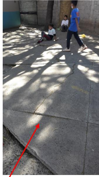
Imagen 1-2. Se observa el mal estado del piso de concreto a la entrada de la Escuela
