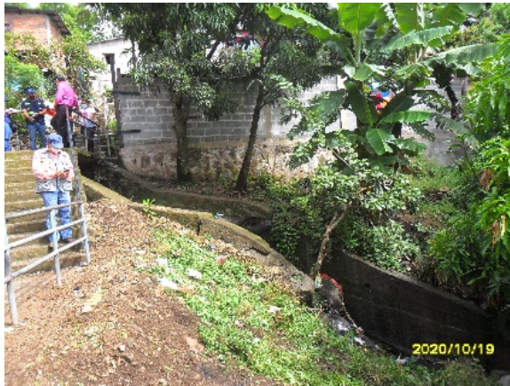
Ilustración 5. Zona de descarga de aguas pluviales cercano a viviendas.
