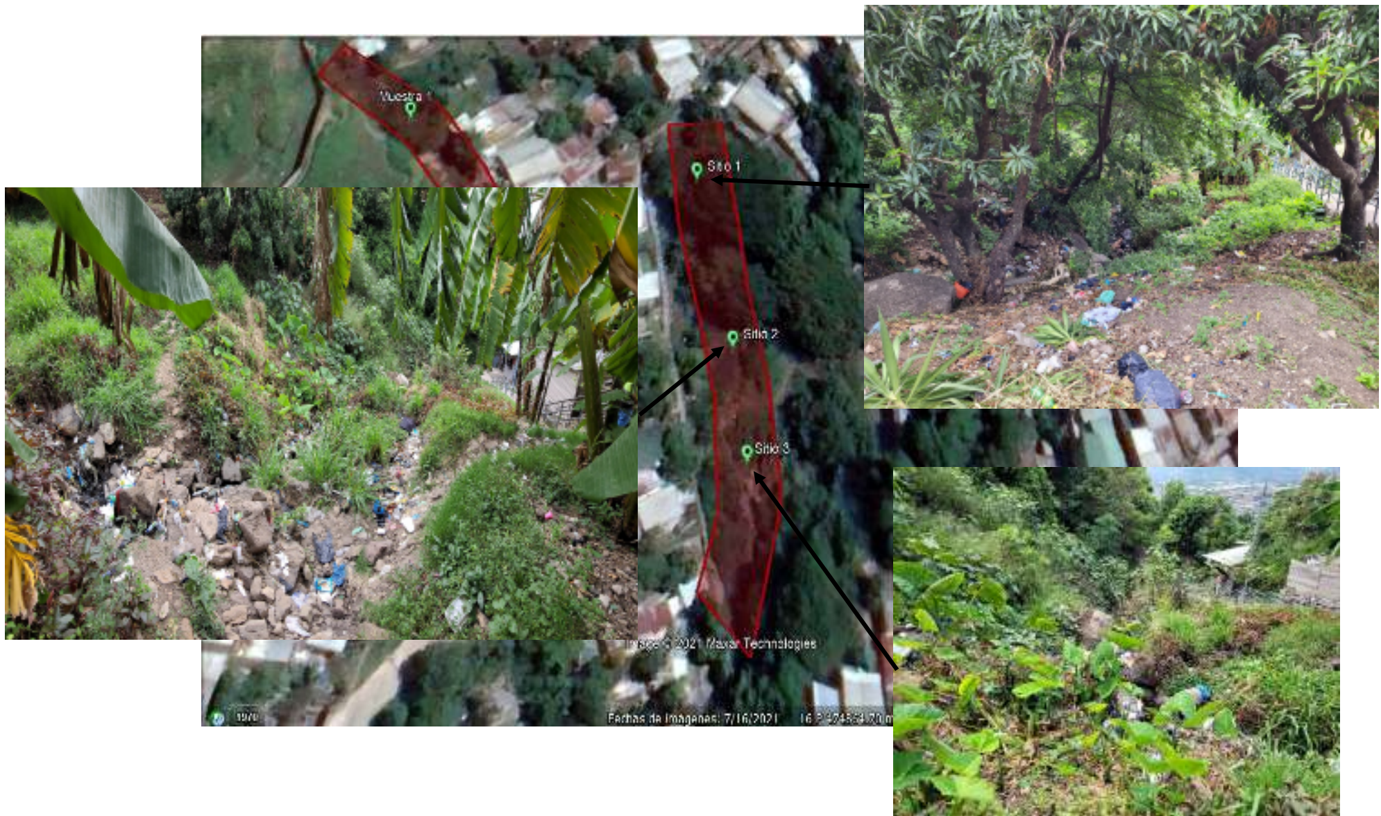
Ilustración 7 Mapeo de suelos en Tramo 2. Nótese los depósitos de ladera en todo el recorrido del cauce. Usualmente estos depósitos suelen estar compuestos de una matriz limosa que encierra gravas y rocas. Siendo este el caso según lo observado in situ.
