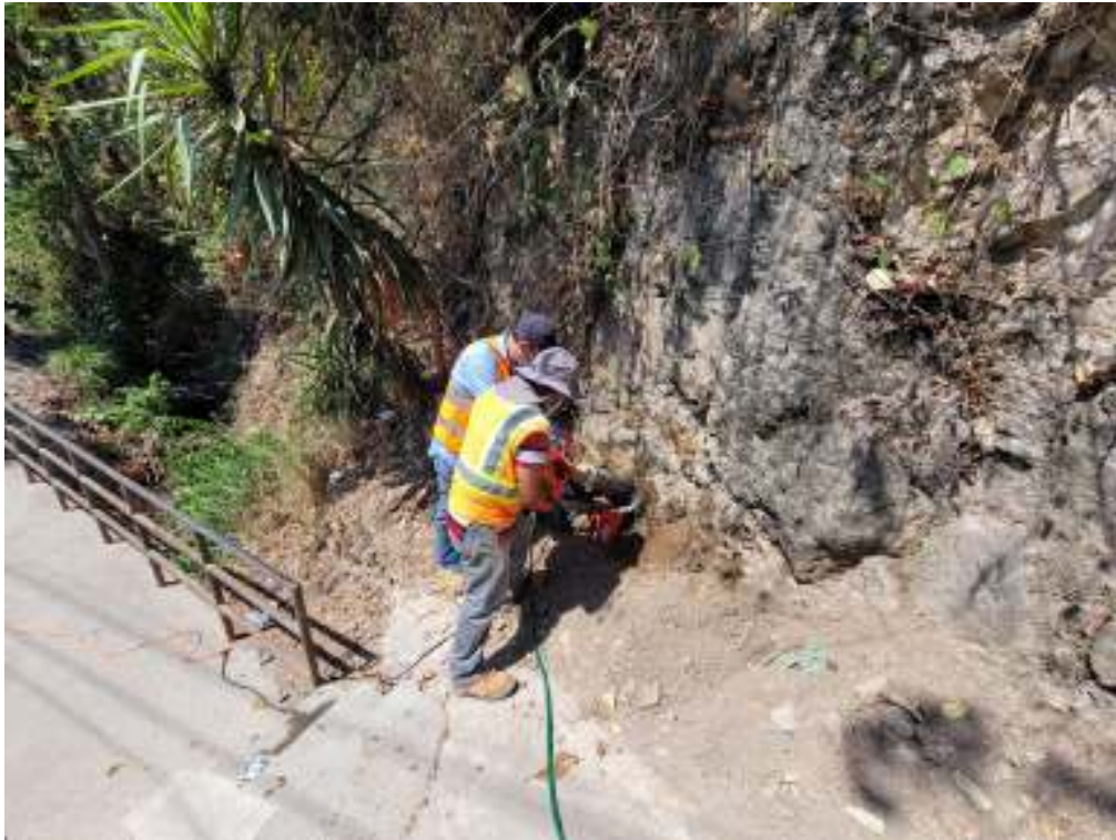
Ilustración 13 Extracción de núcleos de roca.
