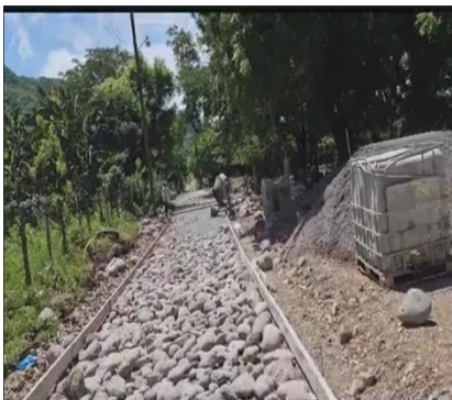
Construcción de pavimentación de concreto 41Ciclópeo E=20 CM, el Zapotillo Municipio de Marcovia Choluteca
