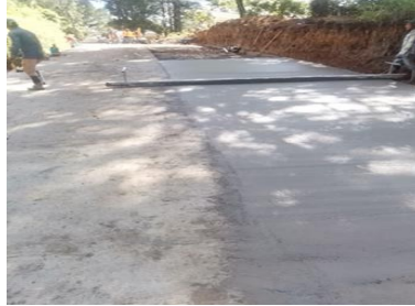
Avances del Proyecto: Construcción de 319 km de Pavimento Concreto Hidráulico en La Comunidad de Yerba Buena Lepaterique
