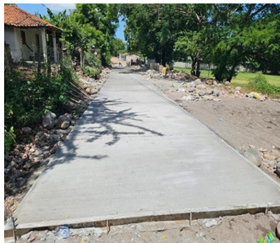
Construcción de pavimentación de concreto 41Ciclópeo E=20 CM, el Zapotillo Municipio de Marcovia Choluteca
