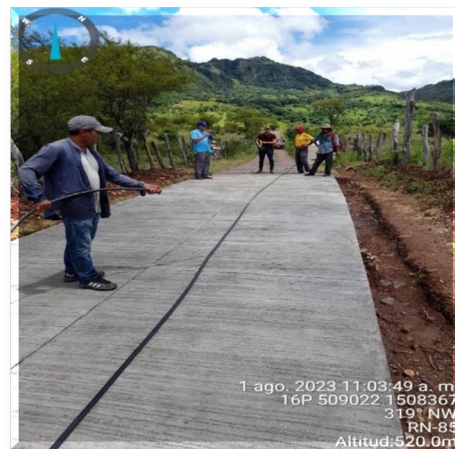
Pavimento 1,041 metros cuadrados con Concreto Ciclópeo E=20CMS en comunidad las Delicias Morolica, Choluteca
