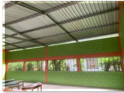
Seguimiento en la construcción edificio de Kínder Santa Elena, Naco a la Municipalidad de Quimistán Santa Bárbara
