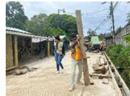
Inspección de construcción de pavimentación del callejón Nelly de Bo. Lomas del Puerto, Sector El Porvenir.
