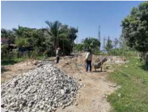
Inspección del proyecto de construcción De centro social de la Col. 14 de agosto, Sector Nuevos Horizontes.
