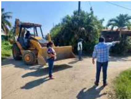
Apoyo al Depto. de Servicios Públicos en La limpieza de canales pluviales de Bo. San Martin, Sector Península Este 2.
