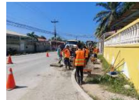
Apoyo al Depto. de Servicios Públicos en la limpieza de canales pluviales de Bo. Suyapa, Sector Península Este 2.
