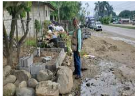
Inspección de la construcción de dos contenedores temporales para depósito De derechos sólidos en Puente Alto, Sector Puente Alto.
