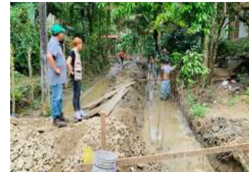
Inspección de proyectos de canales pluviales de La Pita, Sector Ecoturístico.
