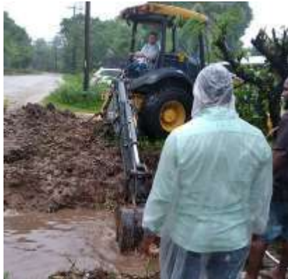
Apoyo al Depto. de Mantenimiento Vial En la limpieza de alcantarillas y pasos De agua de Bajamar, Sector Garífuna.
