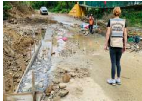
Inspección de proyecto de vado de Agua Caliente, Sector Ecoturístico.
