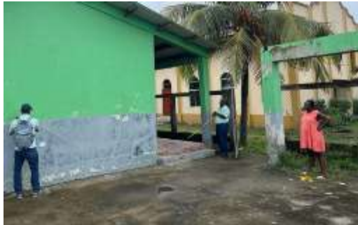
Apoyo al Depto. de Obras Menores en la Evaluación para mejoramiento del techo del Jardín de niños Martha Sara Mena de Bajamar Sector Garífuna.
