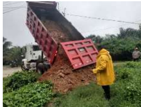
Apoyo al Depto. de Mantenimiento Vial en la entrega de material de cerro para Reforzamiento del bordo de Nueva Ticamaya Sector Ramal de Lima.
