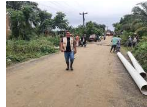
Apoyo al Depto. de Mantenimiento Vial en la instalación de tubo de drenaje para salida de agua acumulada por las lluvias En Nola, Sector Ramal de Lima.
