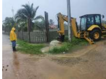
Apoyo al Depto. de Mantenimiento Vial en la limpieza de canales artesanales de Bajamar, Sector Garífuna.
