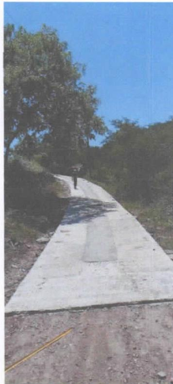
Construcción de Huellas Vehiculares Tramo Carretero el Carbonal E=10 CM
