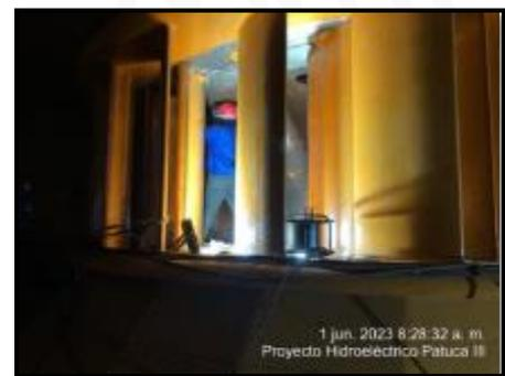
Ilustración 2: Trabajos de Soldadura y pulido de álabes móviles de Unidad Espiral No. 1.
