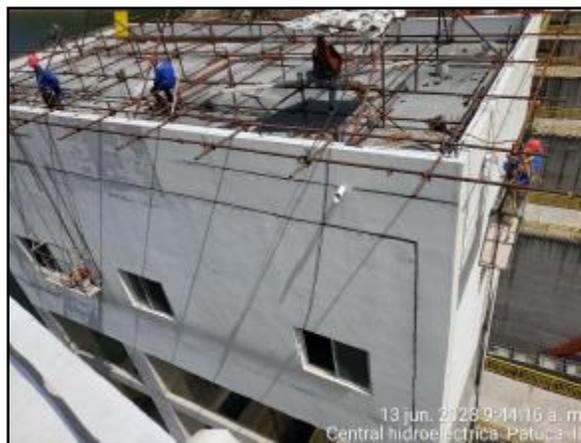
**Escarificado de junta entra marco rígido y paredes de bloque lateral derecha y aguas abajo en cuarto de operación de descarga de fondo.**
