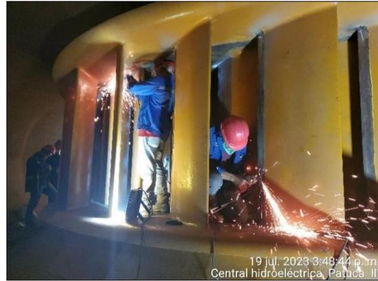
**Trabajos de Soldadura y pulido de álabes móviles de Unidad Espiral No. 1.**
