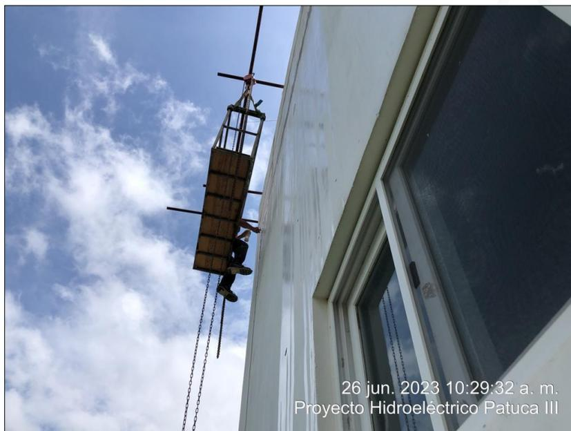
**Aplicación de pintura elastomérica en resanes en junta entre marco rígido y paredes de bloque lateral derecha y aguas abajo en cuarto de operación de descarga de fondo.**
