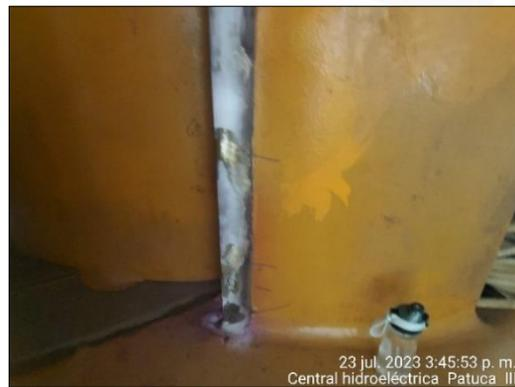
**Pulido de piezas metálicas y trabajos de soldadura en álabes fijos de la Unidad Espiral No. 1.**
