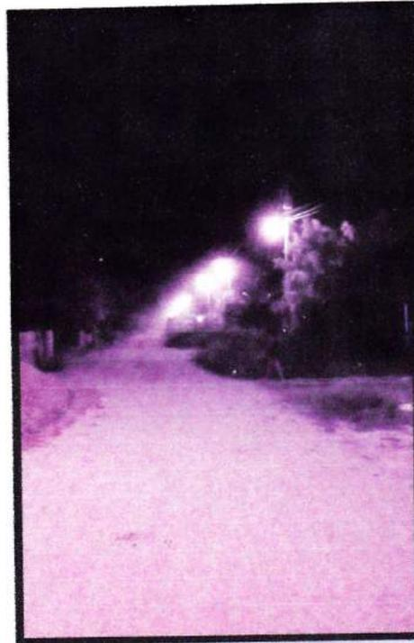
**4.4 Reparación de Alumbrado Público En Sector Barracones Y Colonia 1 De Mayo, Barrio Campo Rojo, Sector Península Oeste.** Consiste en la instalación de 7 lámparas nuevas de 100 watts tipo canasta con su respectivo brazo y fotocelda, la reparación de 20 lámparas de 100 watts y 7 de 250 watts y desmontaje de dos postes en mal estado.
