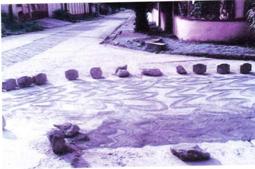
**4.10** Construcción de Canal Pluvial, Colonia Las Lomitas, Sector Pueblo Nuevo. Consiste en Canales Pluviales contruidos con paredes de bloque de 6" armadas con #3@0.40m y tapaderas, canales pluviales con losa de concreto, caja ciega para inspección y cruce de calle. Costo final L. 384,915.87
