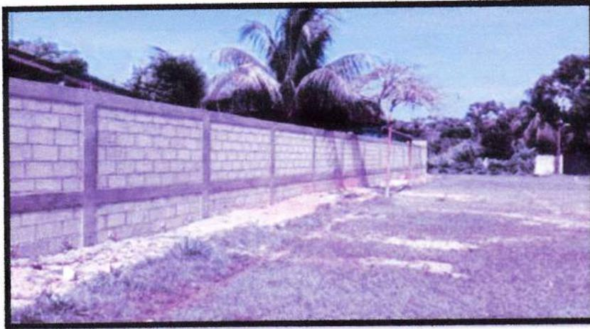
**4.3 Ampliación de Centro Social, Aldea Caoba, Sector Calan.** Consiste de la construcción de cimiento corrido, sobreelevación bloque de 6", elementos estructurales (soleras, castillos,) pared de bloque de 6", piso de concreto, techo con estructura de canaleta, lamina de aluzinc, ventana con tubo estructura y sistema eléctrico.
